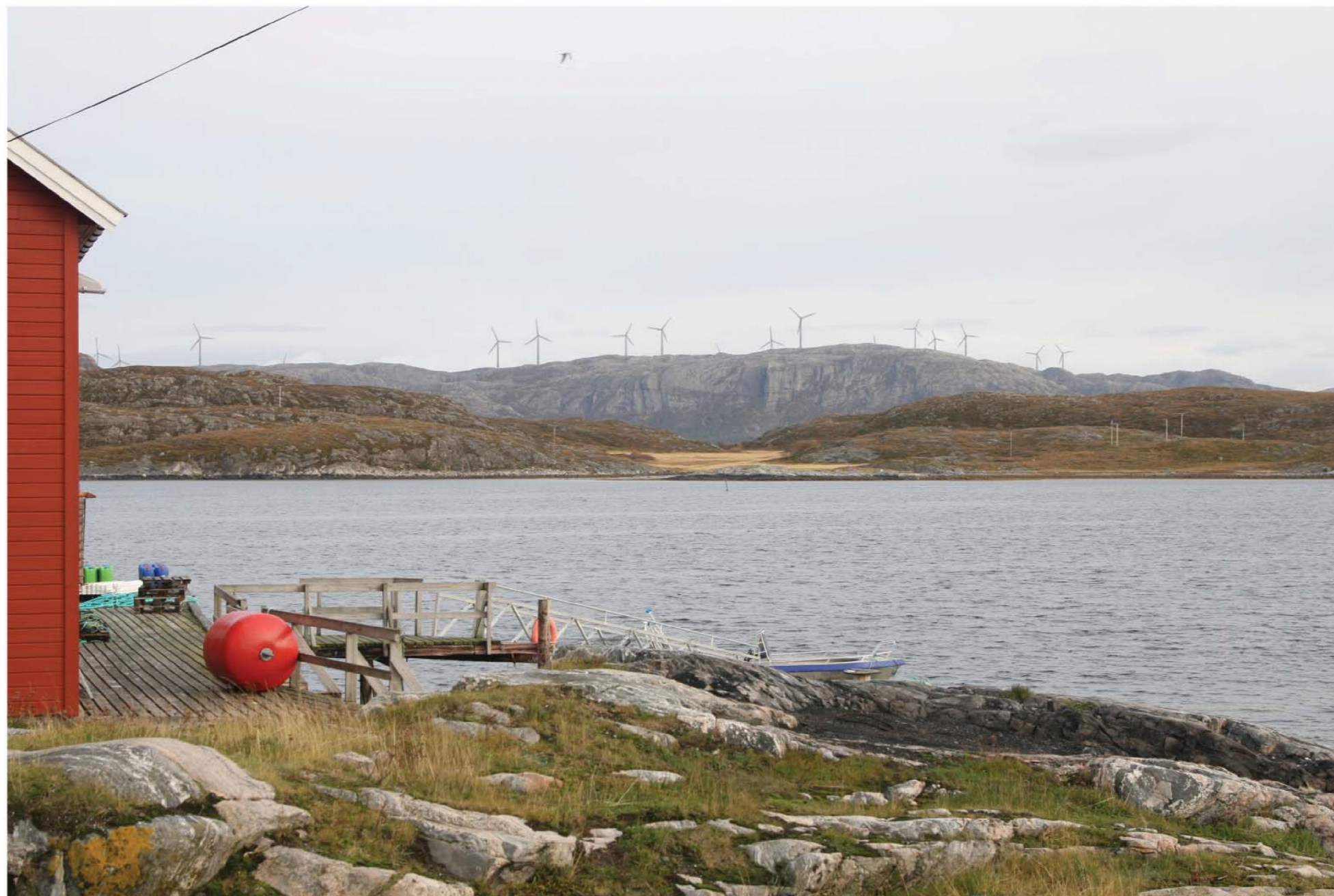
Standpunkt 10. Visualisering fra Bjørøya mot Innvordfjellet. Koordinater for fotostandpunkt: 588593, 7162159 (WGS 84, UTM sone 32) Bildet er tatt mot øst. Foto: Ole Martin Dahle. Visualisering: Borghild Hårstad, Rambøll
