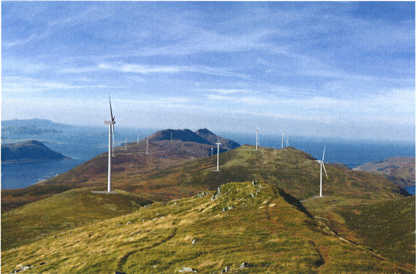
Figur 9: Haugshornet vindpark sett fra Storetua.
