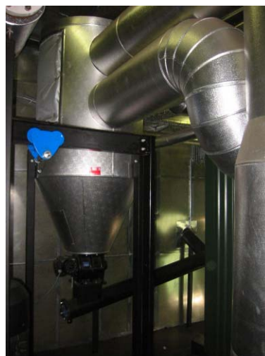
Multisyklon (foto SWECO Grøner AS)
