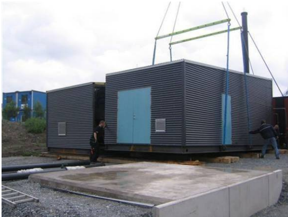
Prefabrikkert bioenergisentral under montasje (foto SWECO Grøner AS)
