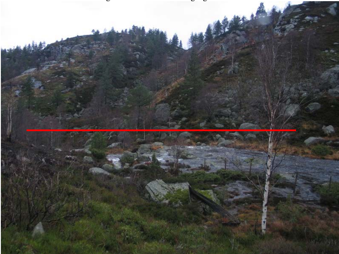
Damsted Østre Neset kraftverk. Damkrope ved rød strek.
