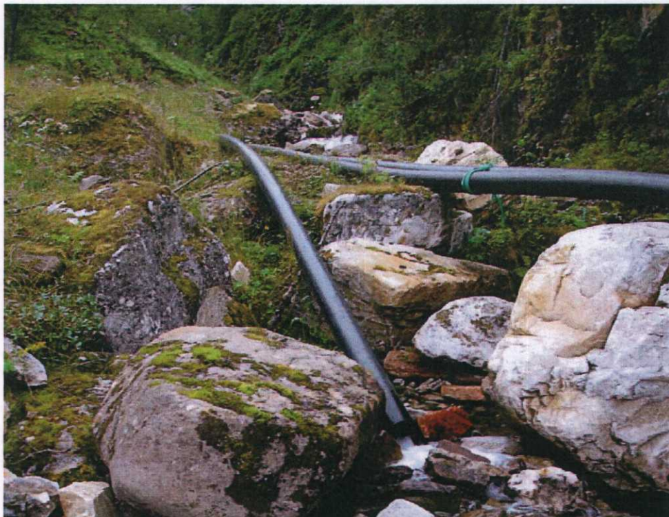
Bilde 5 Og her er rørstussen nedstrøms inntaksdammen som skal kobles til sjøledning nr.3
