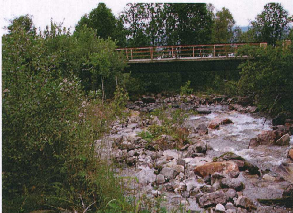
Bilde 8 Den tredje ledningen legges langs elvekanten til venstre og krysser kjørevegen under brua.
