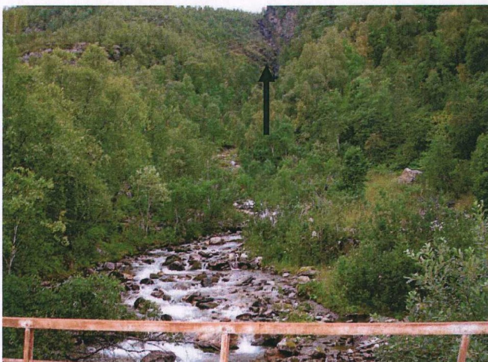
Bilde 9 Elvedalen fra vegen og opp mot inntaksdammen – den trange elvekløfta oppstrøms dammen skimtes øverst på bildet
