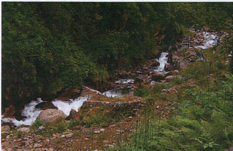
Bilde 2 Øverste del av midlertidig anleggsveg opp til inntaksdammen. Vannledningene skimtes til venstre for vegen.
