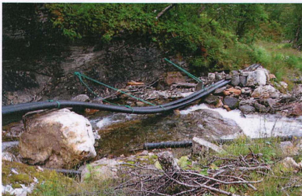
Bilde 6 Dette er det partiet av ledningstraceen der ledningen er synlig (må krysse elva pga. bratt elvebredd – til venstre på bildet)
