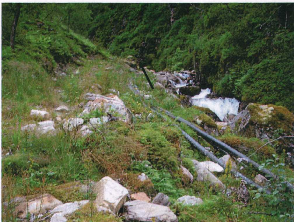
Bilde 4 Anleggsveg (delvis gjengrodd) og ledningsnett sett nedenfra og opp mot inntaksdammen (midt på bildet der elvekløfta smalner inn).
