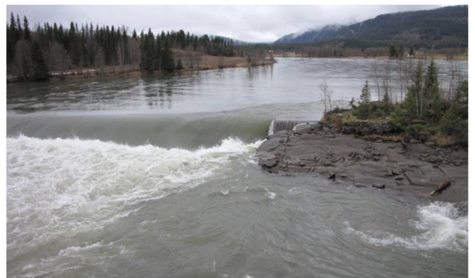
Terskelen ovenfor damlukene som skaper en innsnevring i vannløpet
