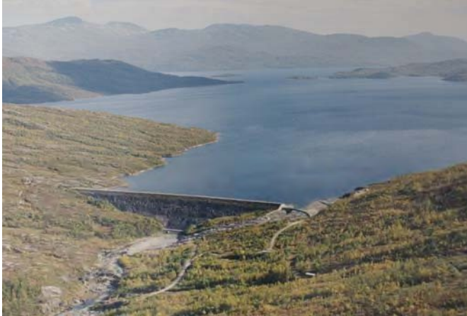
Foto 5 Dam Kalvatn: Foto: Fjellanger Widerøe
