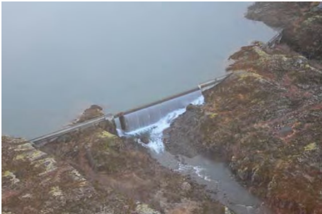
Foto 6 Dam Store Målvatn. Bildet viser fullt magasin og overløp på Målvassdammen. Foto: Statkraft
