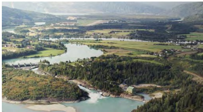
Foto 1 Sammenløpet av Ranelva (fra høyre) og Langvassåga (fra venstre) og Reinforsen dam og fossen i forgrunnen. Reinforsen kraftstasjon ses til høyre for fossen. Foto: Fjellanger Widerøe
