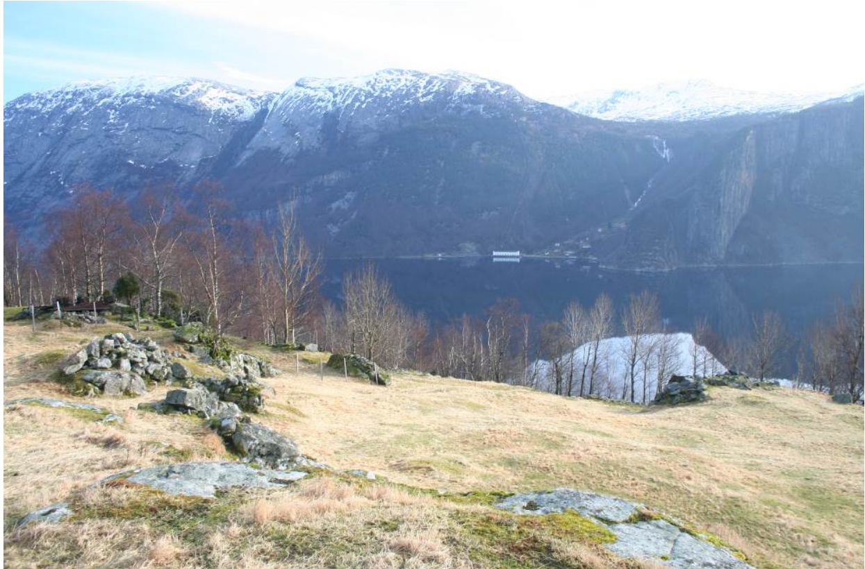
Bilde 4-5. Krafthallen på Flørli sett fra Kosen, delområdet Helmikstølen–Kosen–Tuftene.
