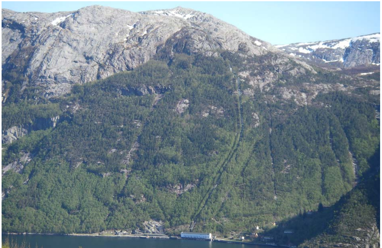
Lysefjorden med Flørli kraftverk
