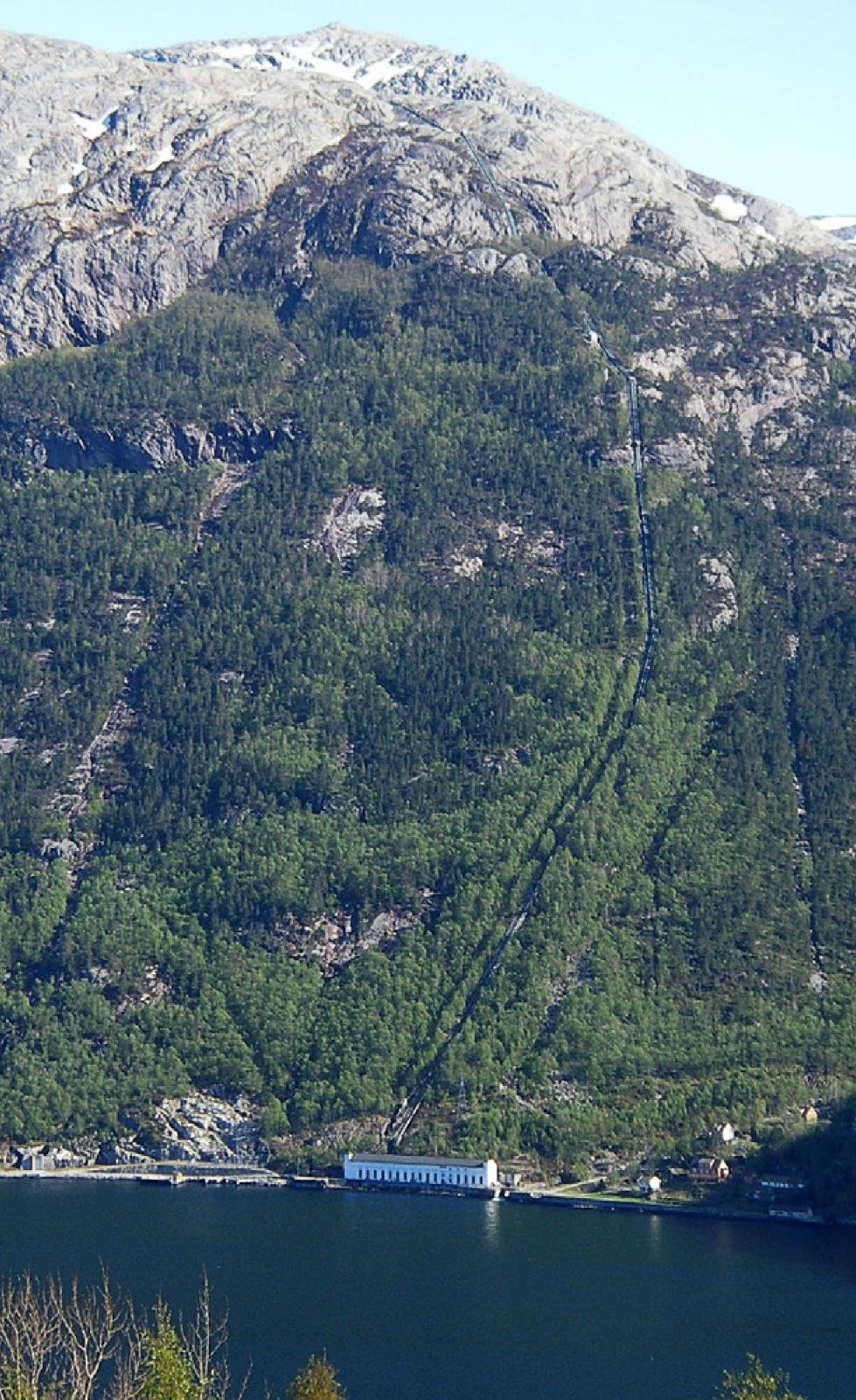
Lysefjorden med Flørli kraftverk.
