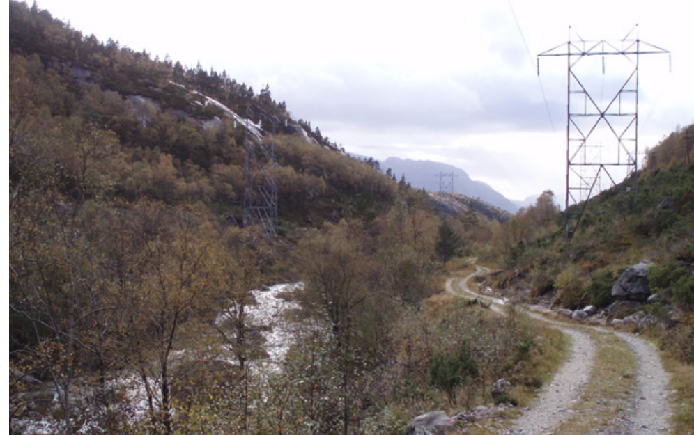
Veg og linjer i Daladalen, sett ned mot Nordåna kraftverk og inntak i Dalaåna.
