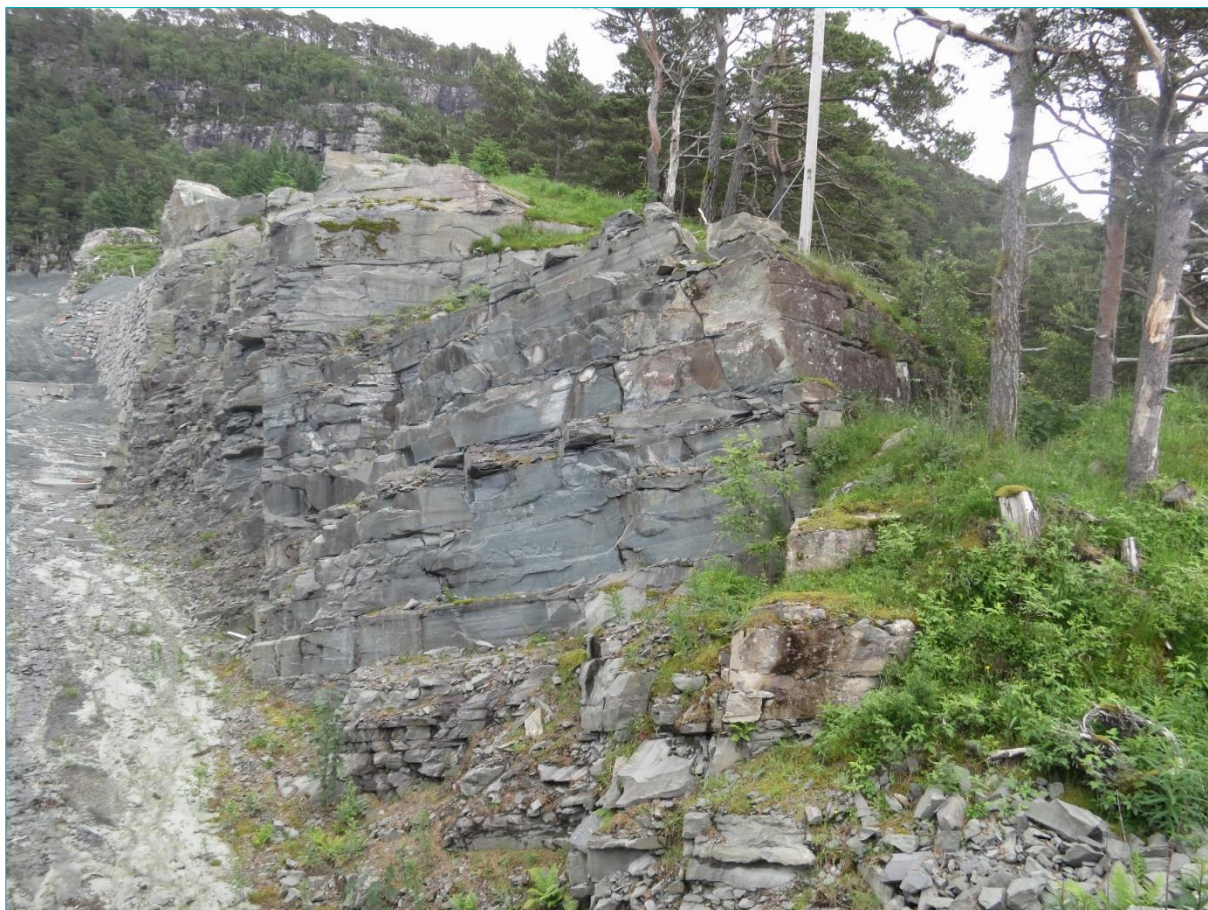
Figur 3: Seljestokk. Typisk skjæringsflate i sandstein på nært hold. Foto: Einar Berg.
