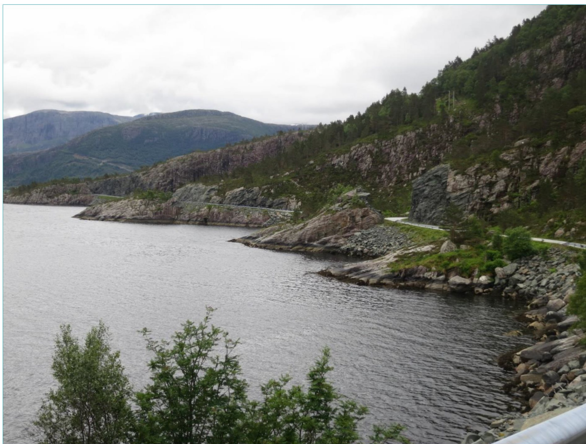
Figur 4: Fylkesvei 577 ved Bratthammarvika. Selv relativt ferske og store fjellskjæringer danner liten grad av kontrast til tilgrensende bart fjell. Den nærmeste store skjæringen er ca. 200 meter unna, den bakerste ca. en halv kilometer unna. Foto: Einar Berg.
