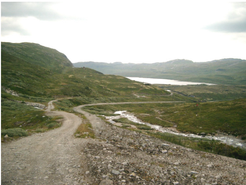
Figur 15 Rørtraséen følger veien mot Mannsbergvatn fra kraftverket og oppover dalen (Fotomanipulert bilde som viser inngrepet før re-vegetering)
