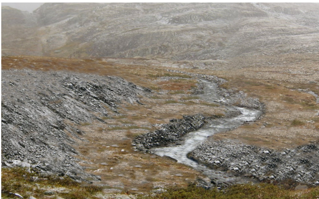
Figur 21 Istandsatt tipp hvor avstanden til eksisterende bekkeløp er vist (manipulert bilde)
