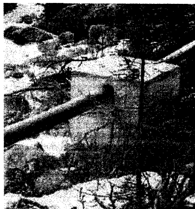
Røyrgate som er forankra på betongfundament, minikraftverket i Ullensvang
