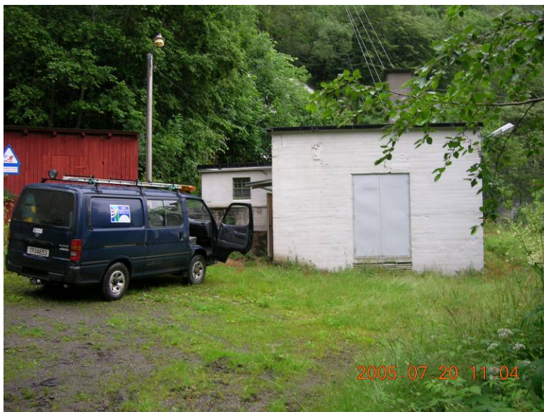
Frå dagens kraftstasjon (Foto: NINA)
