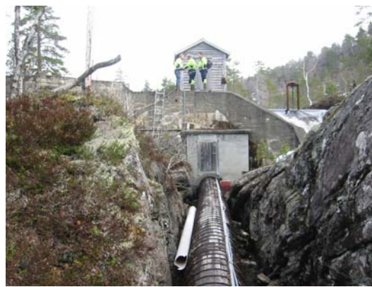
Bilde: Eksisterende inntak som skal ombygges til enhet for tapping av minstevann.
