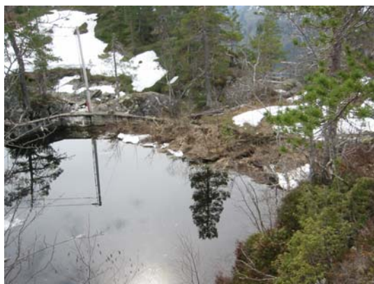
Bilde: Dammens høyre side hvor det skal settes opp ny betongmur til erstatning for eksisterende fylling
