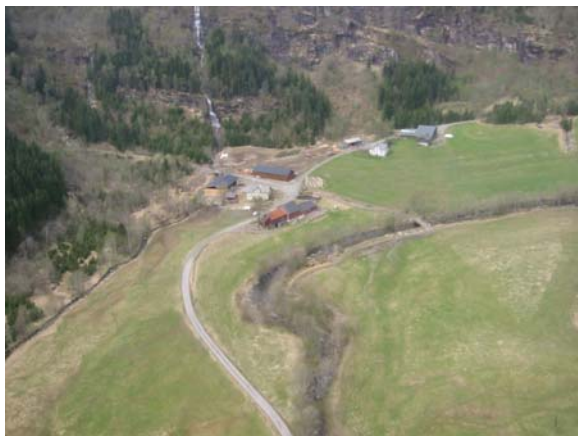
Bilde: oversikt over øvre del av jorder som planlegges hevet med sprengstein fra tunnel
