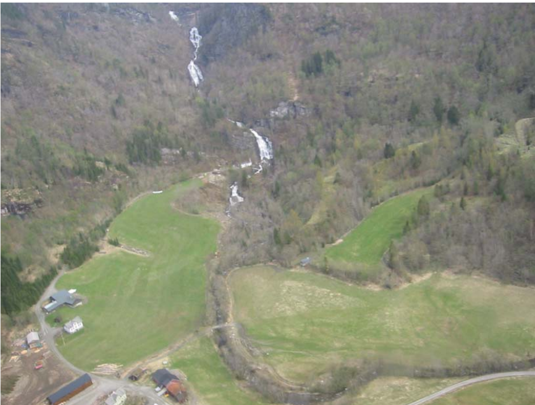
Oversikt som viser vassdraget ved kraftverket. Eksisterende kraftstasjon i bakgrunnen.
