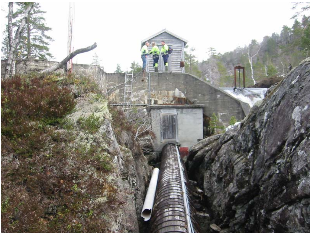
Eksisterende dam med eks. tilløpsrør
