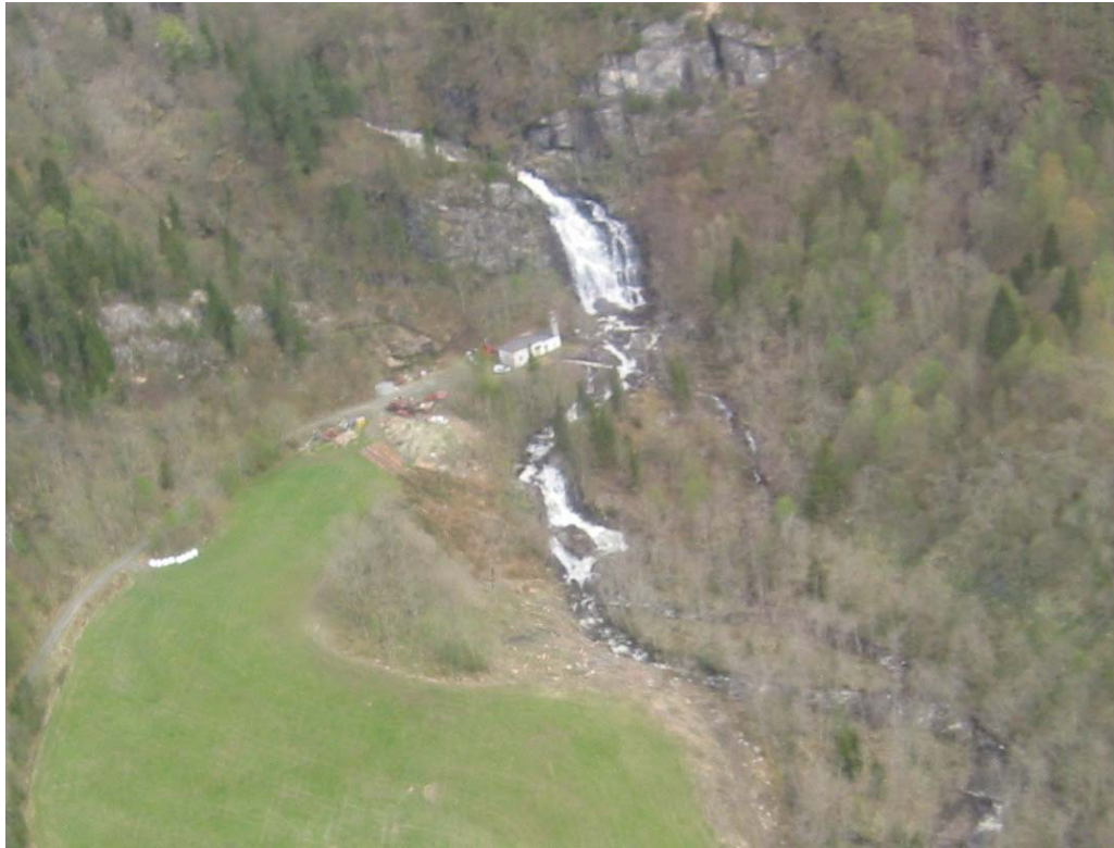
Område med eksisterende kraftstasjon og plass for planlagt ny stasjon i nedkant av fossen (skummende vann)
