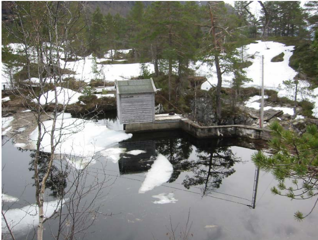
Eks. inntak og dam.
