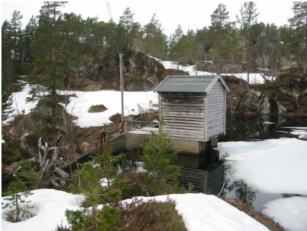
Eks inntak og dam
