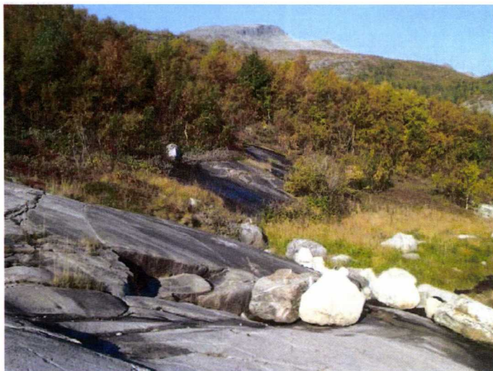
Foto nr 1. Viser området for kraftstasjonen
