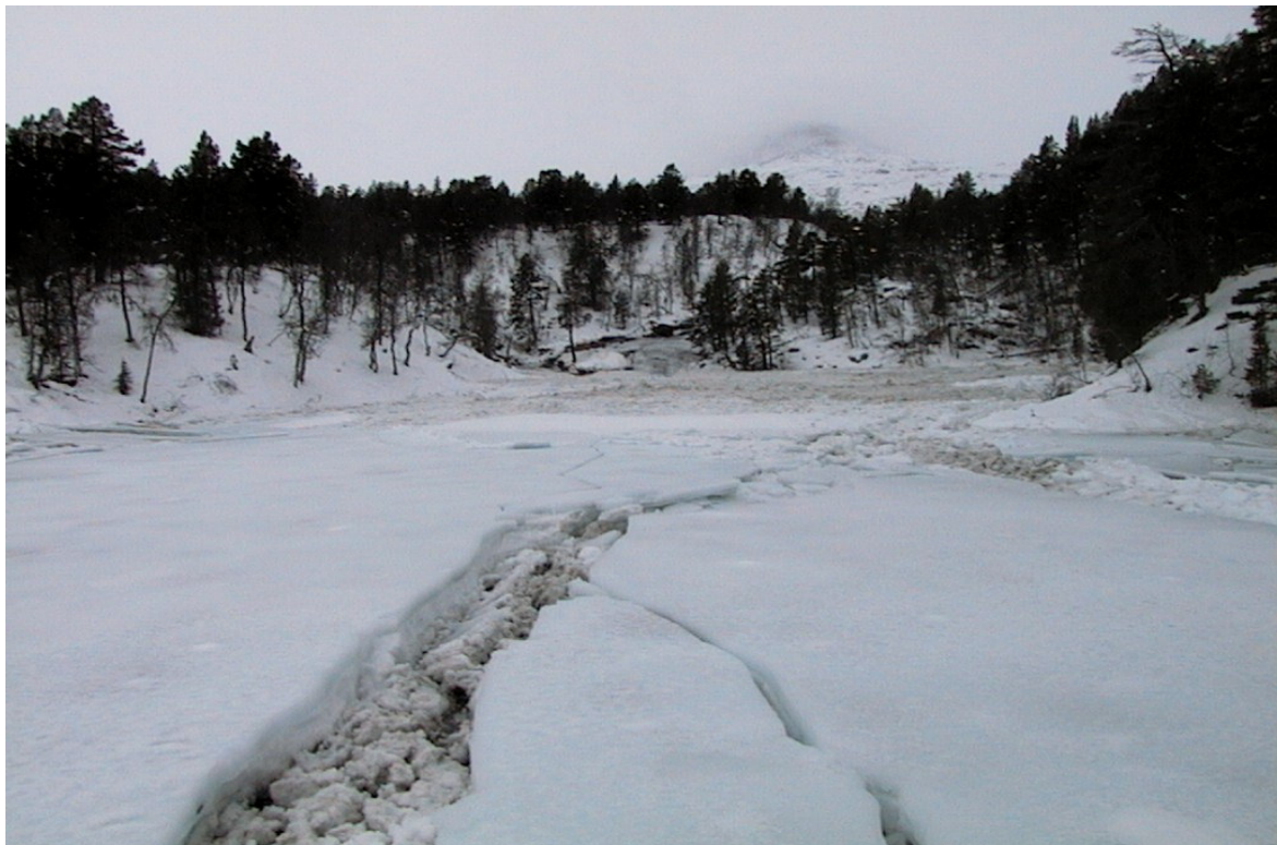
Inntaksbassenget - sommer og vinter
