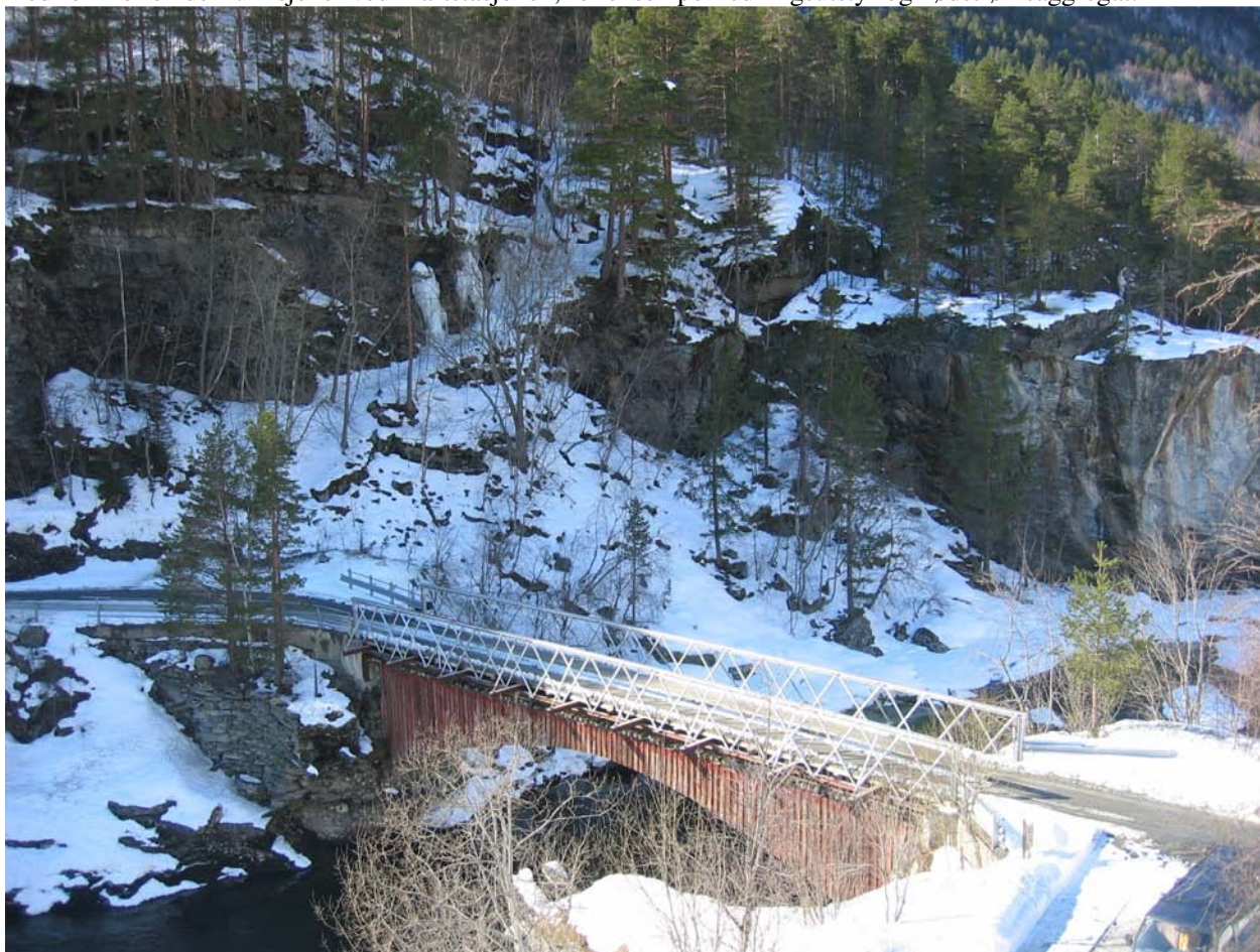
Ormemsbrua. Påhogg for adkomsttunnelen i skrenten bak
