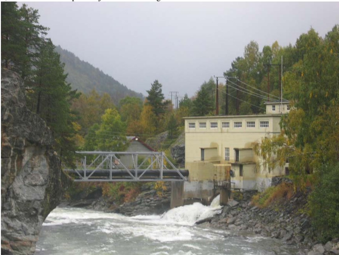
Dagens kraftstasjon med rørbru og avløp
