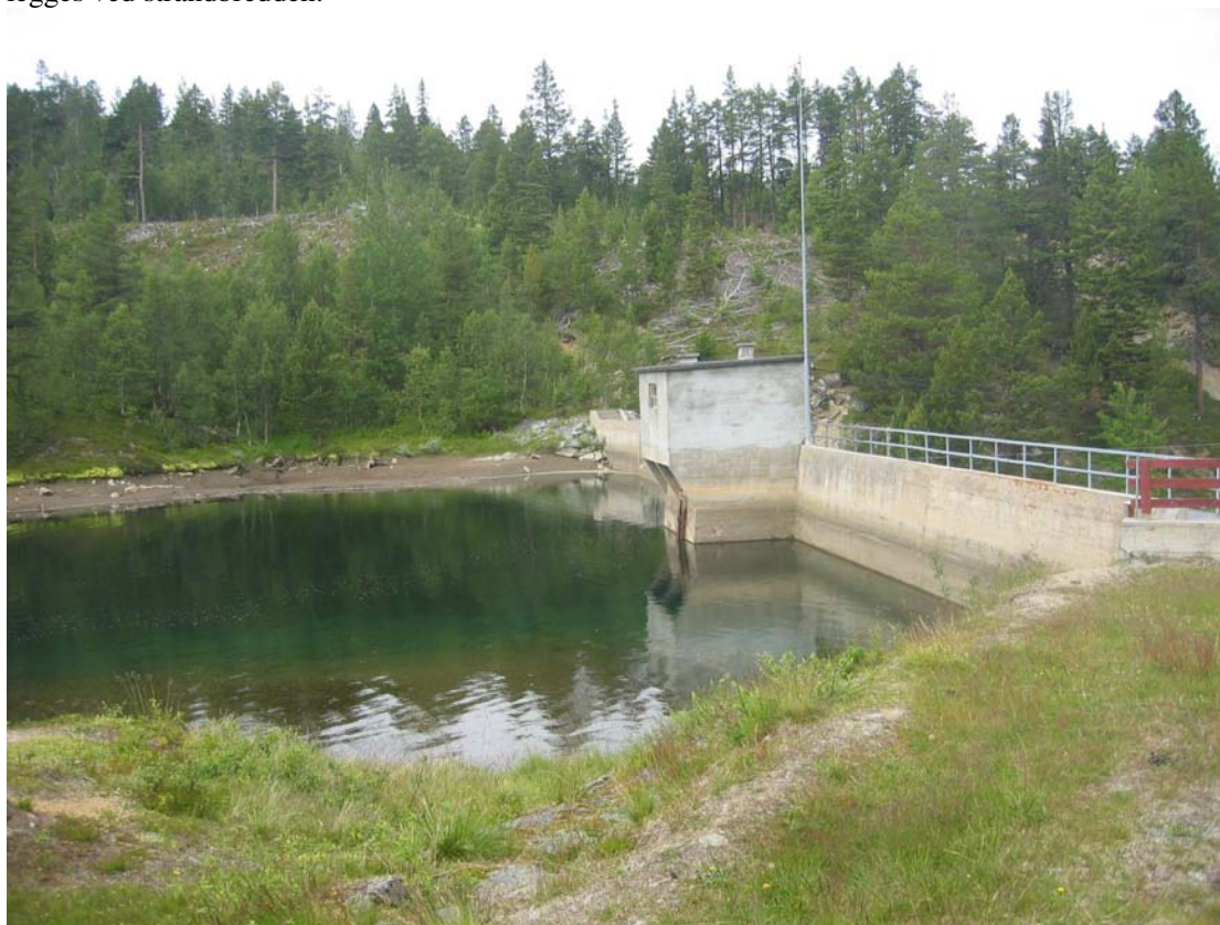
Det nye inntaket vil ligge på ryggen bak lukehuset på bildet etter at dammen er forhøyet
