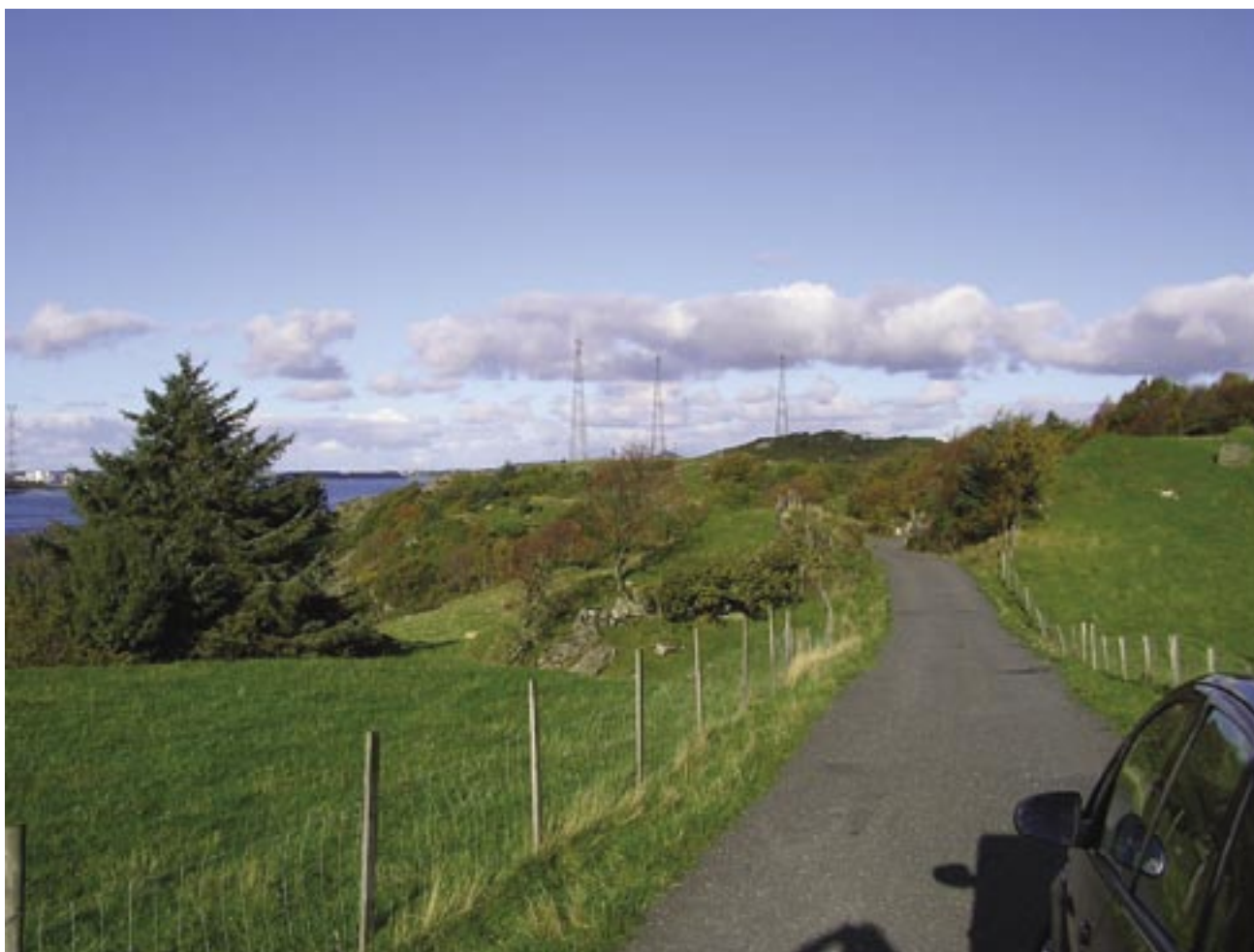
Mastene på Fosenhalvøya, med karmsundet og Hydro Aluminium til venstre på bildet.
