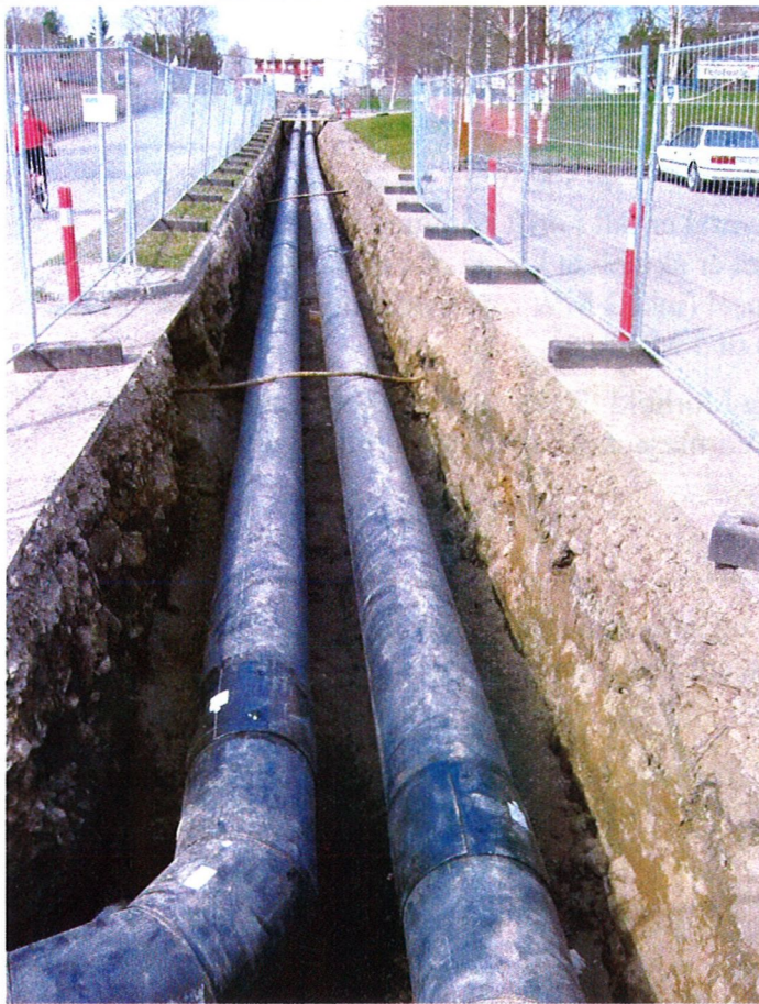
Figur 6-1, Fjernvarmenett under bygging i Hamar
