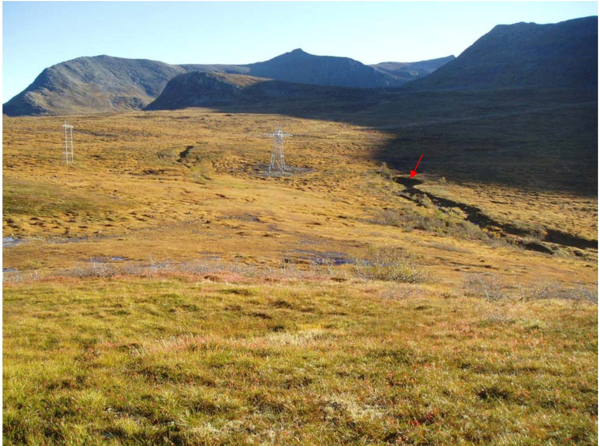
Inntaksområdet til Godvikbekken til høyre på bildet. Kanalen vil gå mot venstre.
