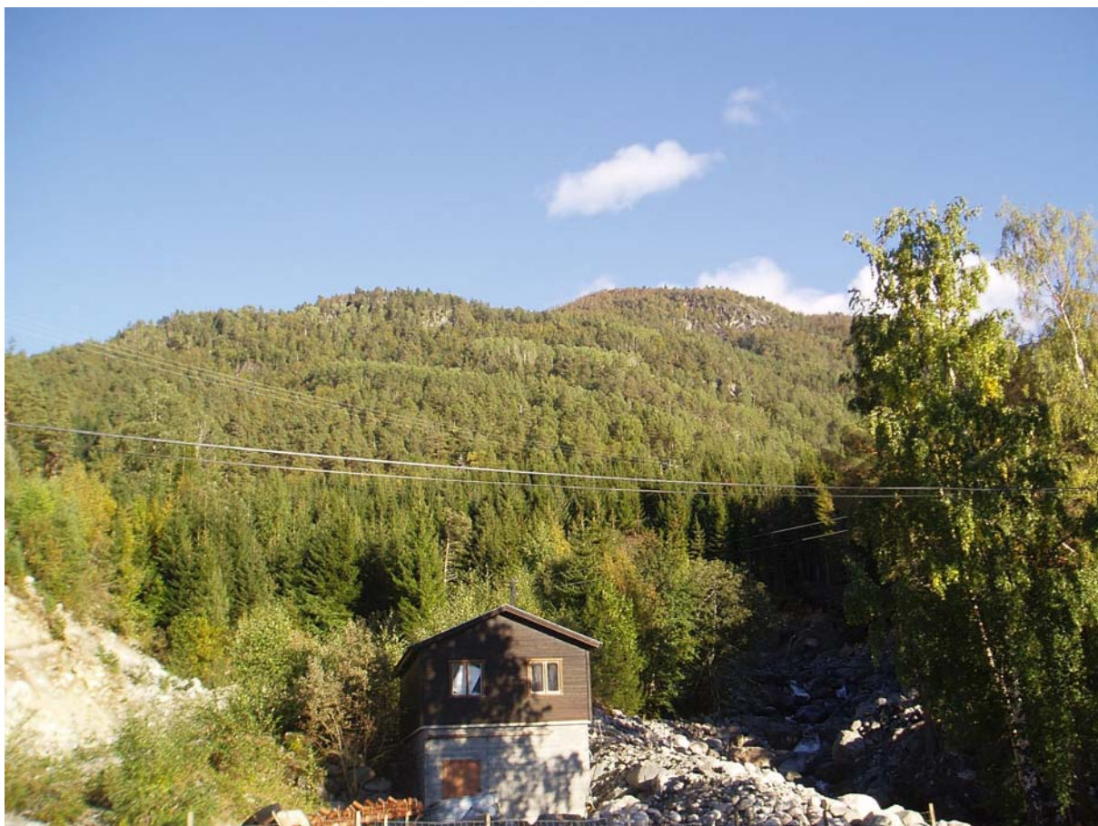
Bildet viser Grytneselva ved kote 50. Transformator ved Grytneselva er ca 70 m til høyre for dette bildet.
