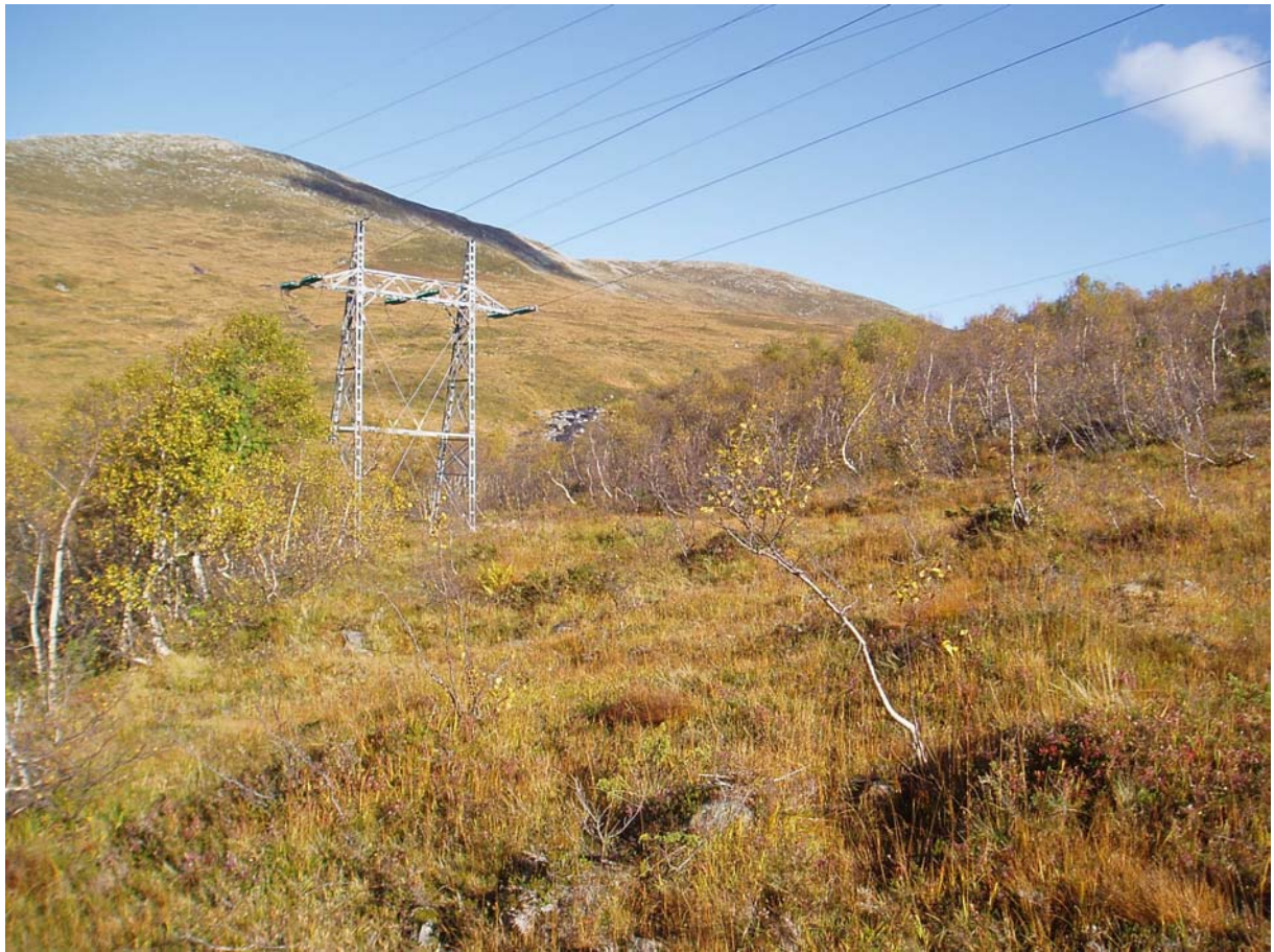
Område for rør i grøft fra inntaket og nedover
