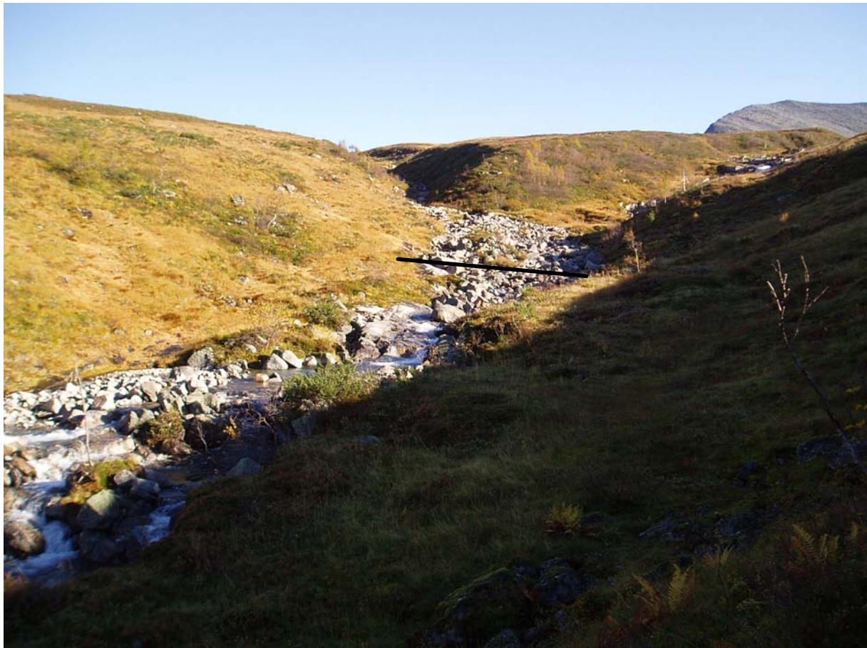
Dam- og inntakssted for Grytneselva kraftverk. Svart strek illustrerer plassering av dam. Farge og dimensjon på symbolet er tilfeldig.
