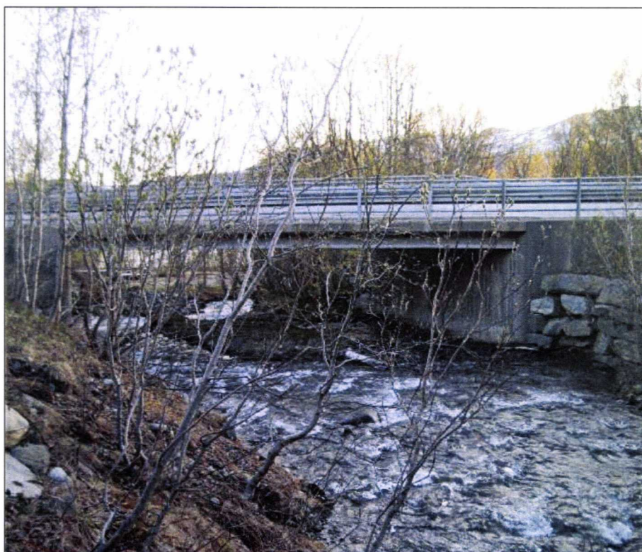
Bilde 12: E6 brua over Fosselva. Lysåpning 12x3m. Foto: Elvekraft
