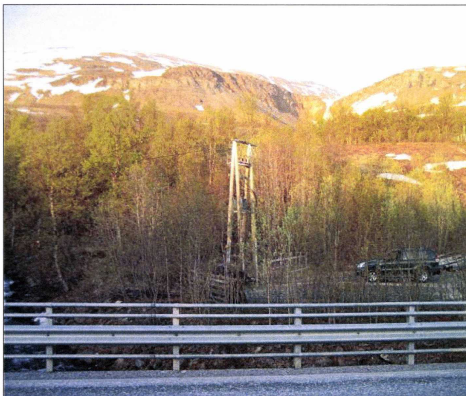
Bilde 11: Stasjonsområde til venstre for høyspent masta. Foto: Elvekraft
