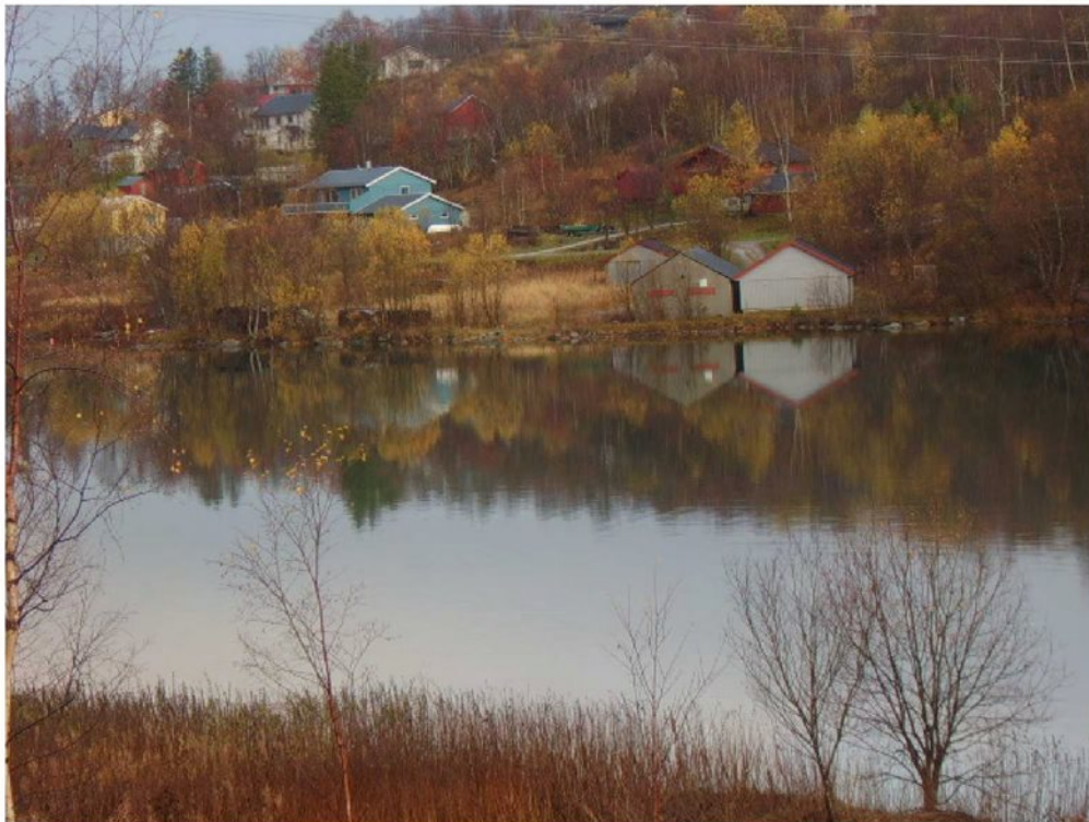
Bilde 1. Viser pumpehus/inntakshus ved vannkanten på andre siden
