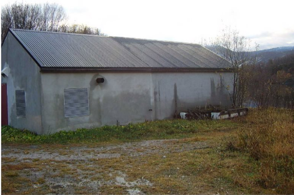
Bilde 2: Viser pumpehus/inntakshus
