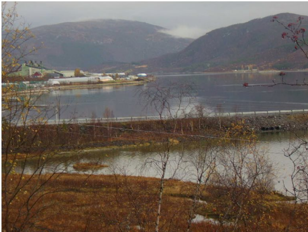
Bilde 6: Viser fylling med E6. Til høyre ses varerør for fremtidige vannledninger til Sisomar og Elkem Salten.
