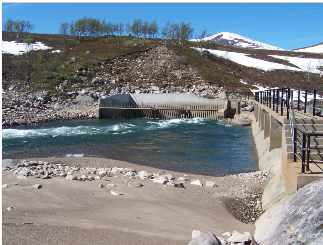
Bilde 1: Bildet viser eksisterende tunnelinntak til Ranaanleggene, like nedenfor planlagt kraftstasjon som blir til venstre for bildet.
