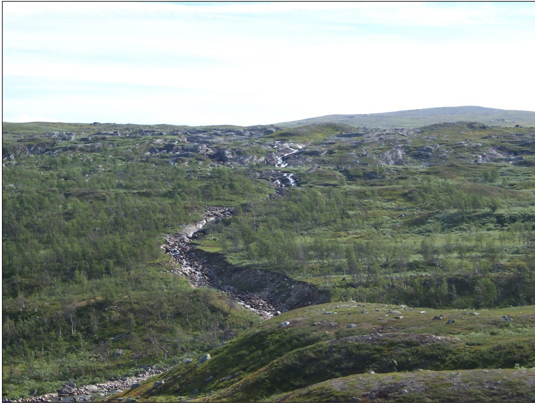
Bilde 7: Som bildet viser er det til dels store erosjonsskader i nedre del av kunstige Sølvbekken. Rørgaten blir liggende på venstre side av sølvbekken sett fra nedstrøms side.
