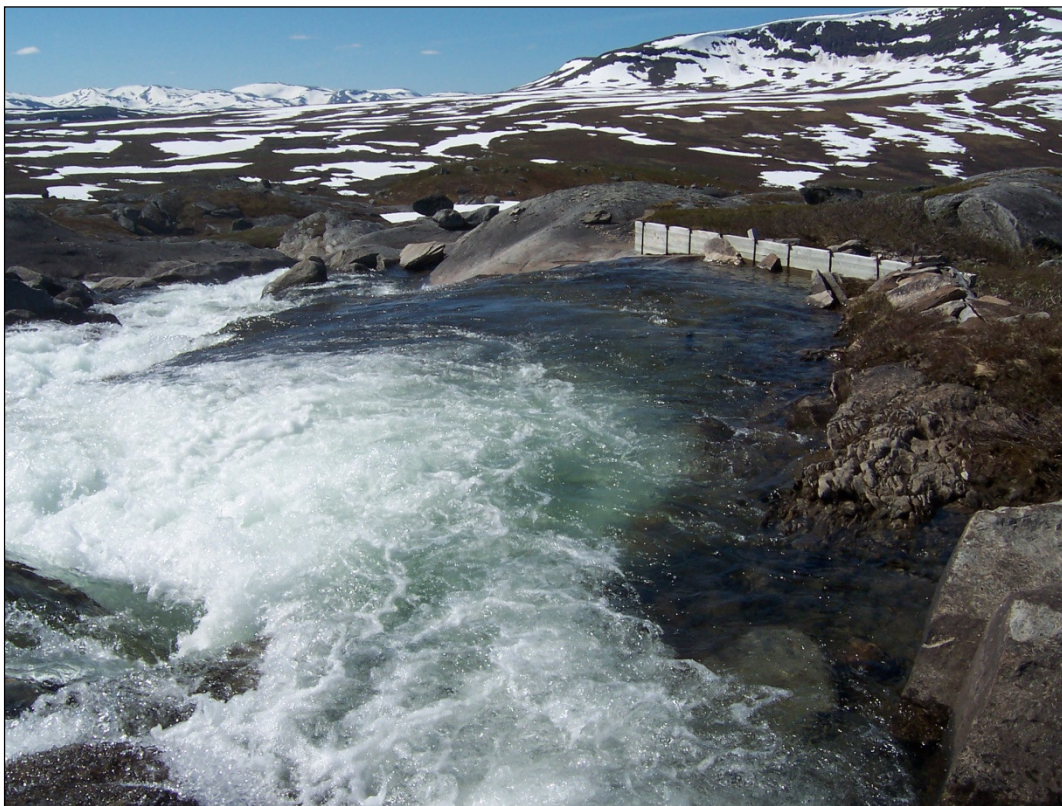
Bilde 16: Planlagt inntakssted. Det bygges en lav betongterskel i eksisterende bekkeløp til venstre i bildet, eksisterende vannforebygning fjernes og ny inntaksdam etableres til høyre for bildet.
