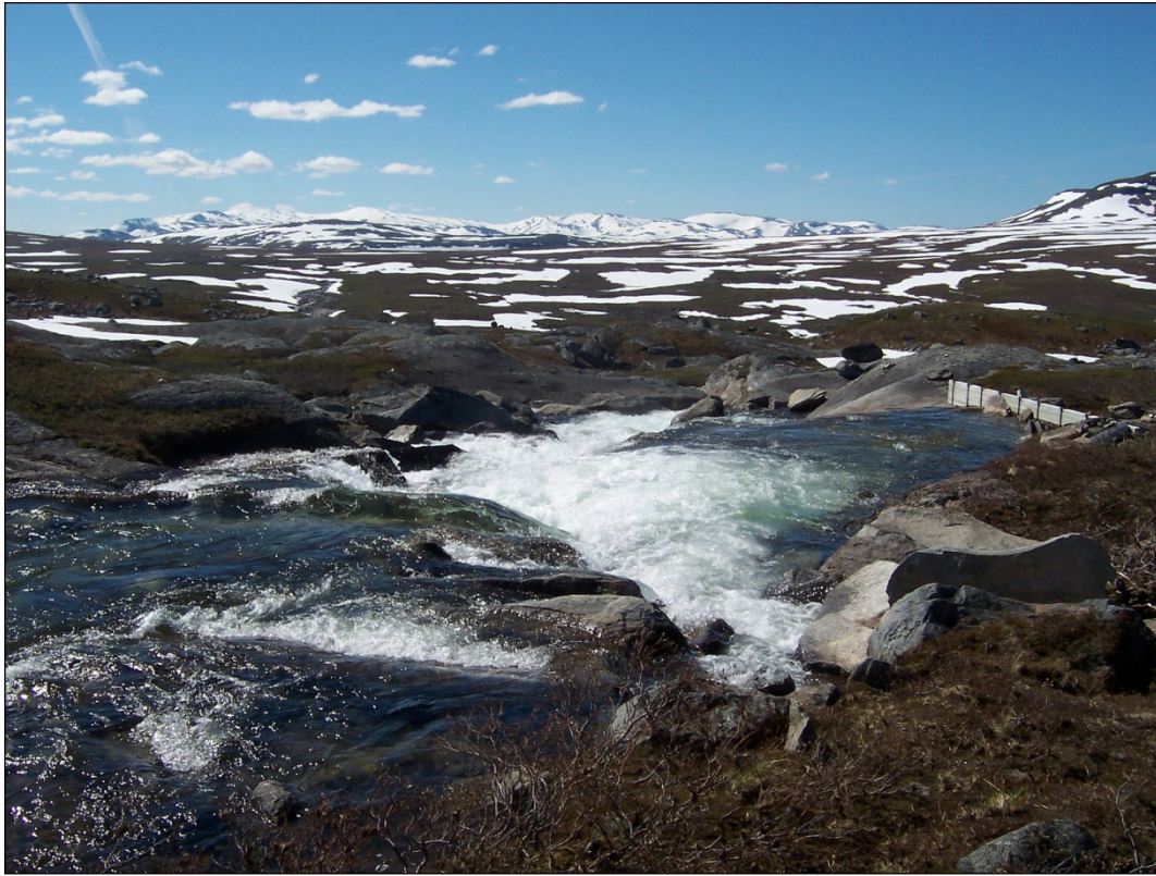
Bilde 17: Planlagt inntakssted. Det bygges en lav betongterskel i eksisterende bekkeløp rett frem i bildet, eksisterende vannforebygning fjernes og ny inntaksdam etableres til høyre for bildet.
