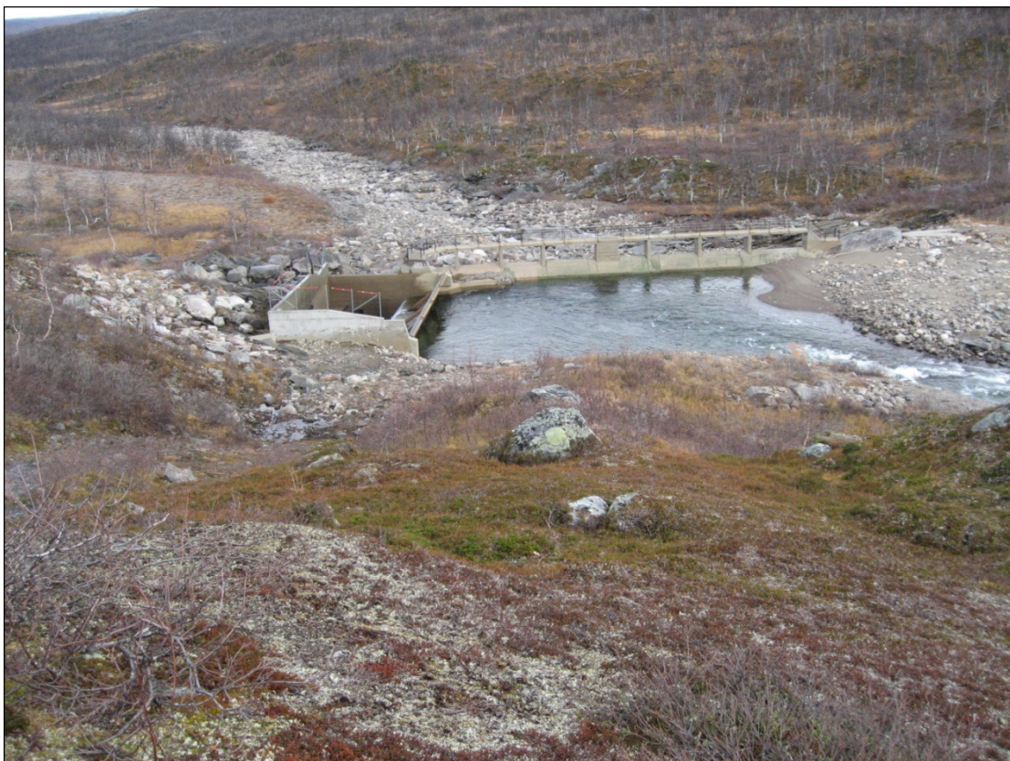
Bilde 4: Bildet viser eksisterende tunnelinntak sett ovenfra, avløpskanalen får sitt utløp helt til høyre i bildet.
