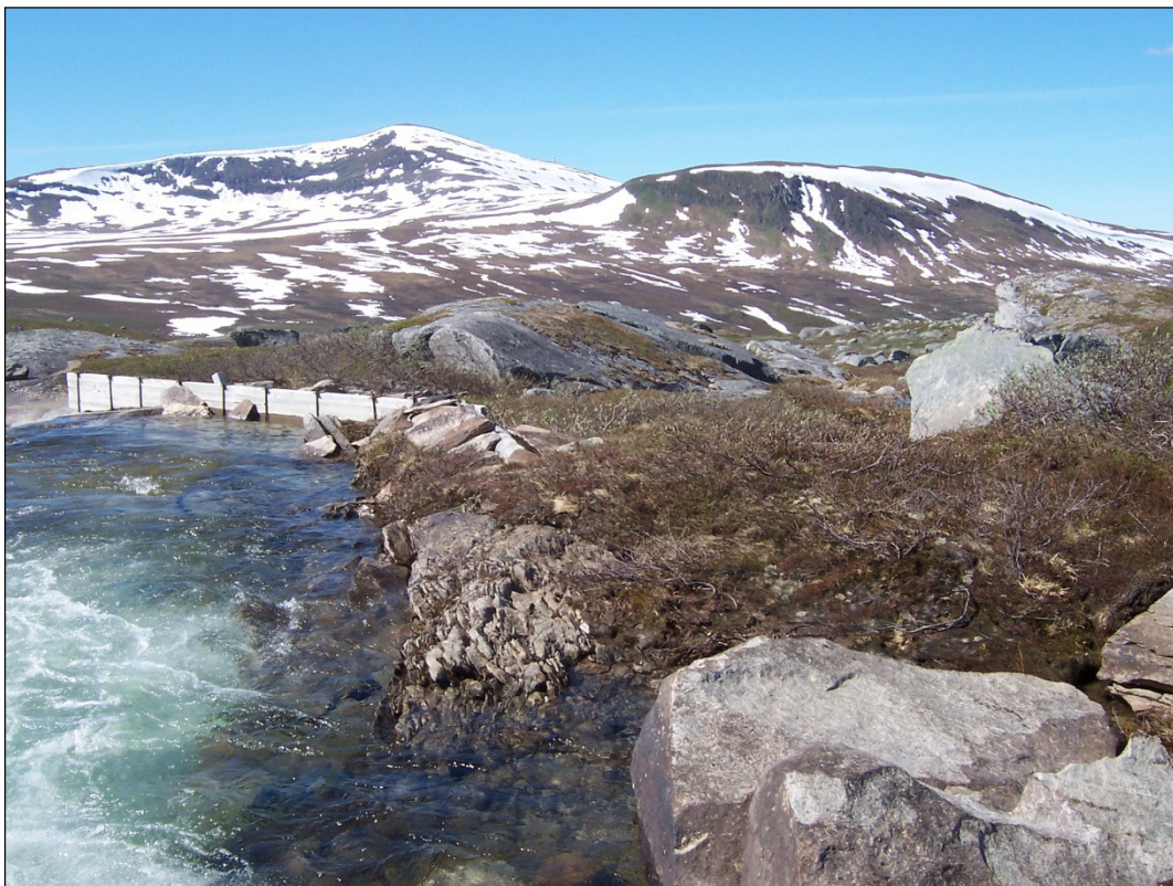
Bilde 14: Planlagt inntakssted. Det planlegges bygd en lav betongterskel i eksisterende bekkeløp til venstre for bildet, eksisterende vannforebygning fjernes, vannløpet (tidligere flomløp) sprenges dypere og ny inntaksdam etableres mellom bergnabbene rett frem i bildet.
