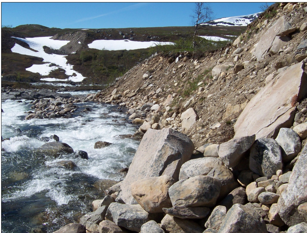
Bilde 10: Som bildet viser er det til dels store erosjonsskader i nedre del av kunstige Sølvbekken.
