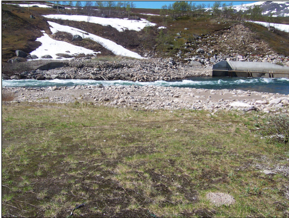
Bilde 17: Nedre del av rørtraseen alternativ B / kraftstasjonsplasseringen. Eksisterende tunnelinntak ligger like til høyre i bildet.
