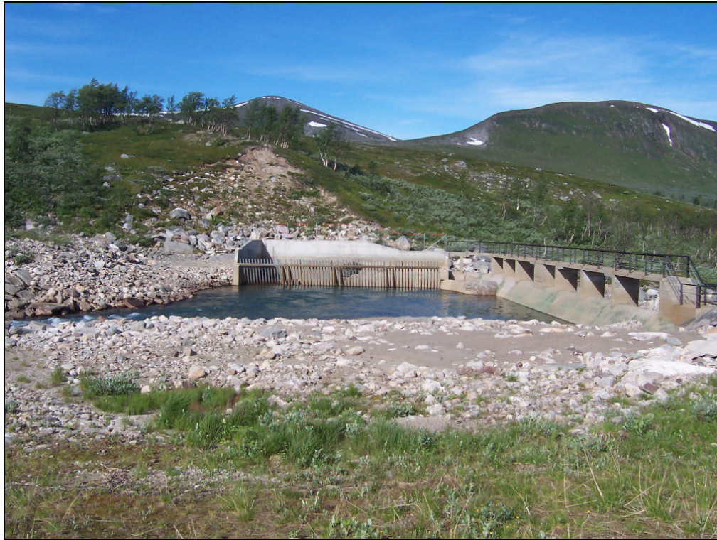
Bilde 1: Eksisterende vanninntak overføringstunnel Rana kraftverk.
