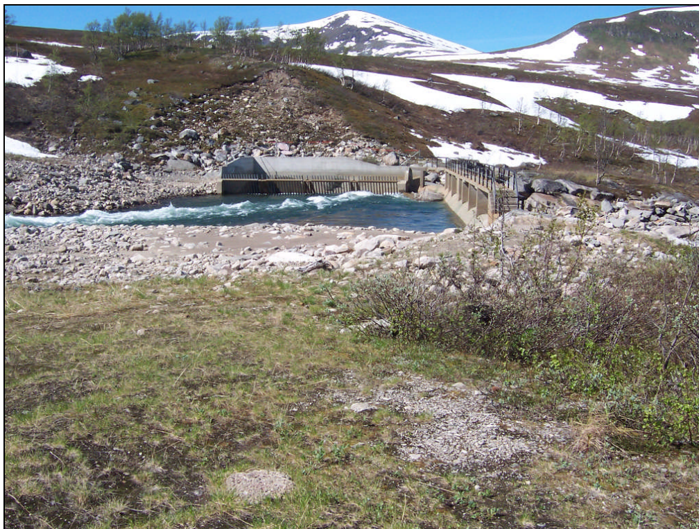
Bilde 18: Nedenfor planlagt kraftstasjon alt. B. Vanninntak overføringstunnel tilhørende Rana kraftverk.
