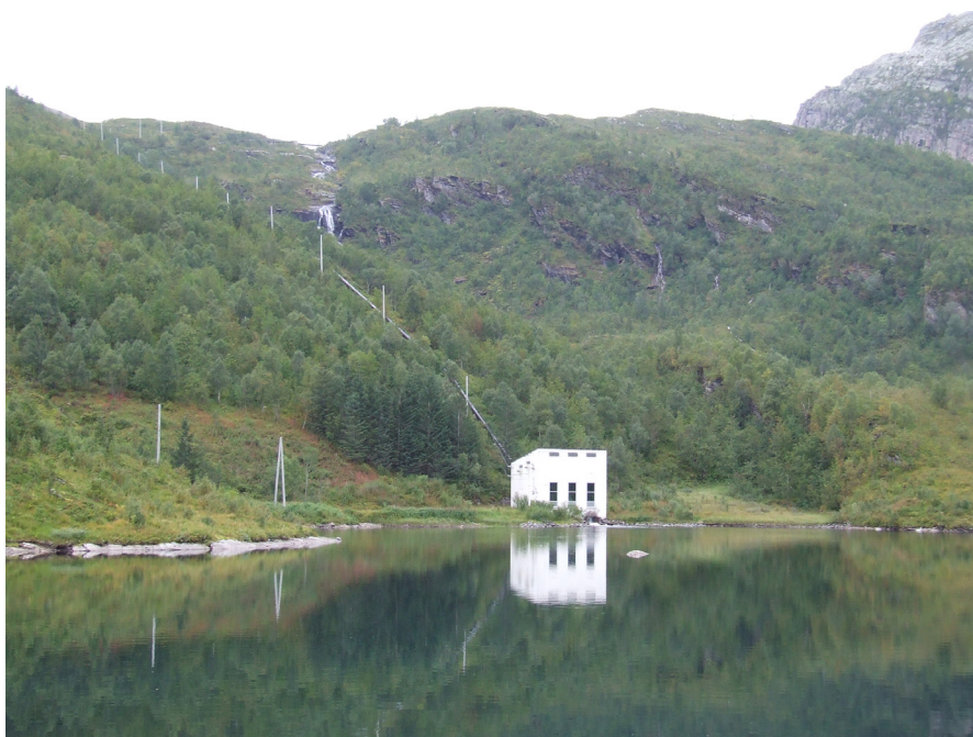
Figur 7. Neverdalsåga kraftverk. Trykkrøret skimtes opp mot venstre.
