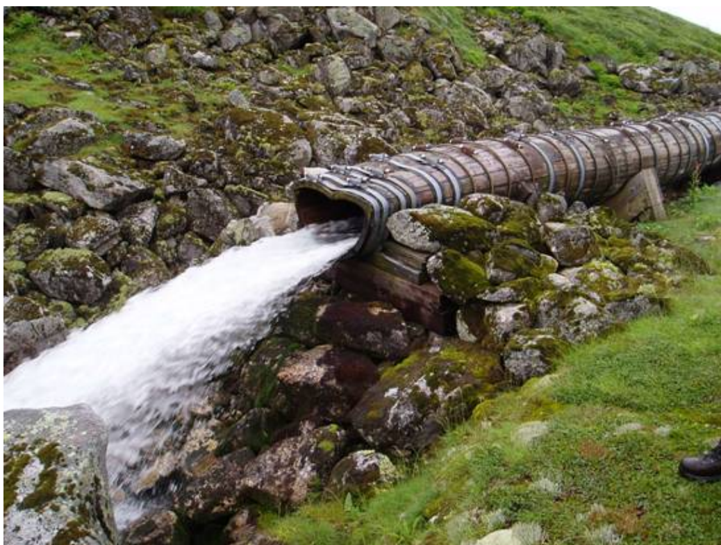
Figur 3. Trerøret som overfører Haugvikåga til Øvre Glomvatnet
