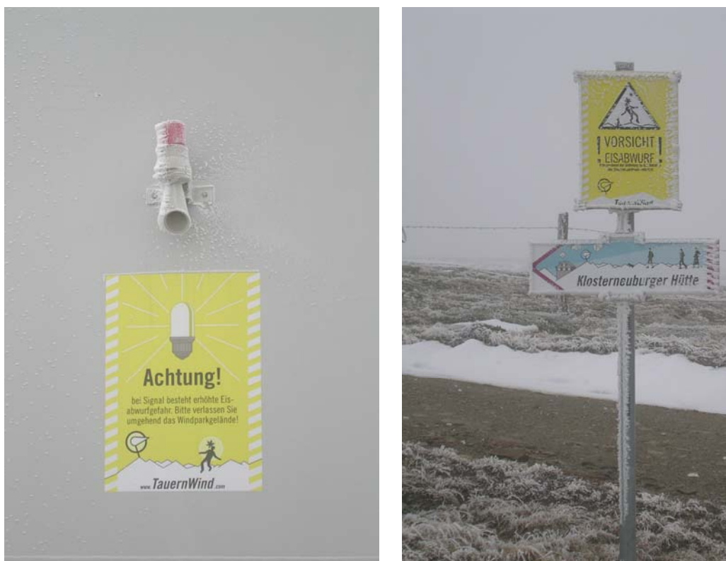
Figur 11 Eksempler på merking og varslingssirene ved fare for iskast fra vindturbiner i Sveits.
