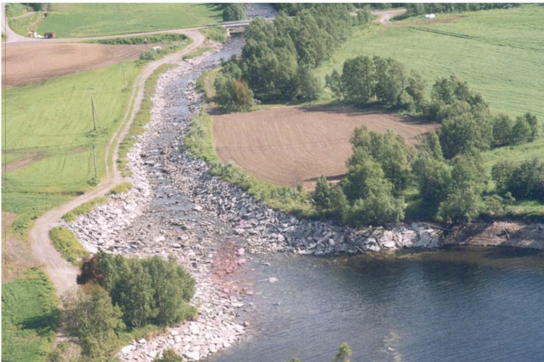
Erosjonssikringstiltak ved Liminglielvas uløp i Limingen
