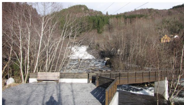
Bildet (11) til høyre er tatt fra en gangbro et stykke nedstrøms Haugafossen. Vannføringen var på det tidspunktet like over 16 m 3 i sekundet.
