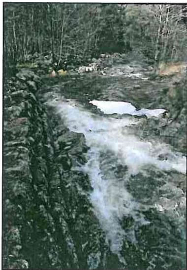
Figur 17: Forbygging i nedre del
