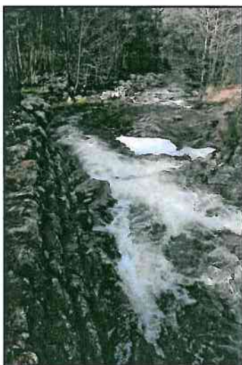
Figur 5.4 Forbygging i nedre del
