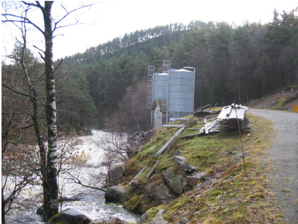
Bilde 3: Nåværende kalkingsanlegg.
