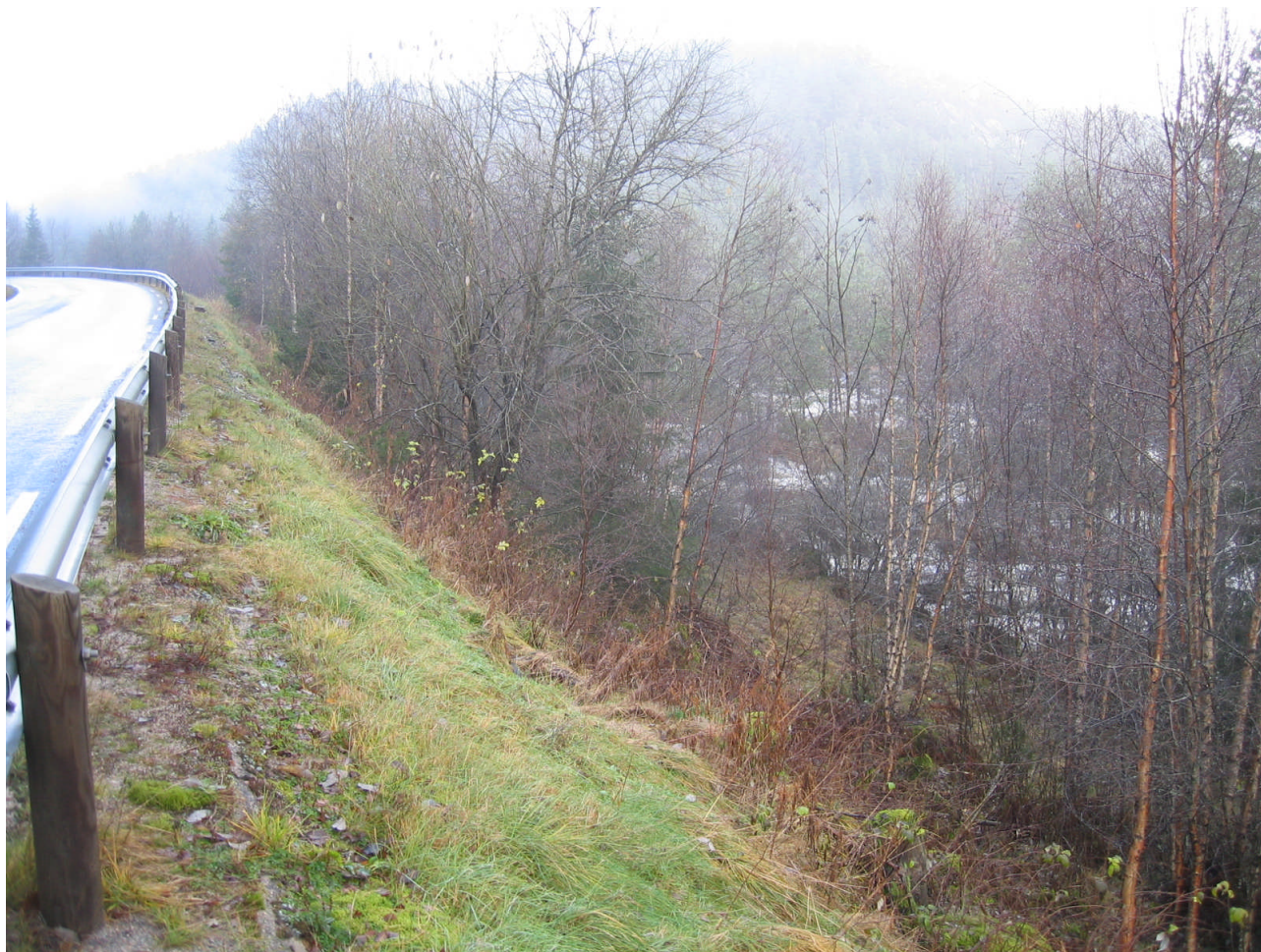
Bilde 2: Nedre del av rørtrase legges i traktor veien som skimtes i midten av bilde
