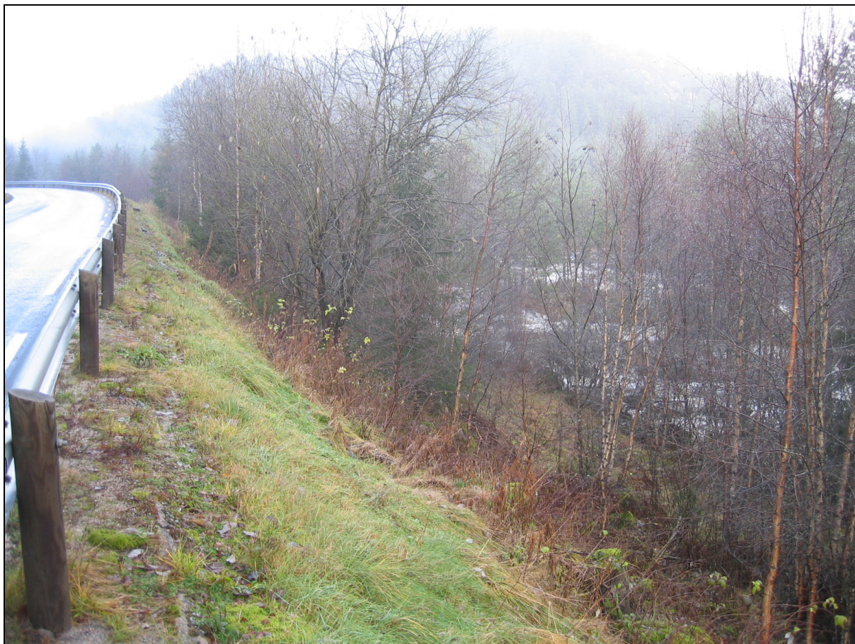
Bilde 2. Fra de nedre delene av vannveitraseen som følger den delvis gjengrodde traktorveien (skimtes til høyre i bildet). Riksvei 42 ses til venstre i bildet.
