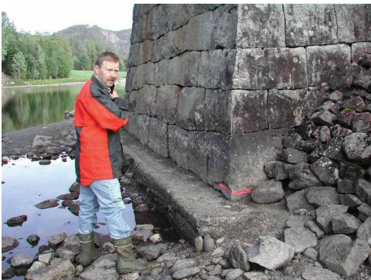
Bilde viser merke for vannstand ved Rustebakke bru etter utbyggingen.
