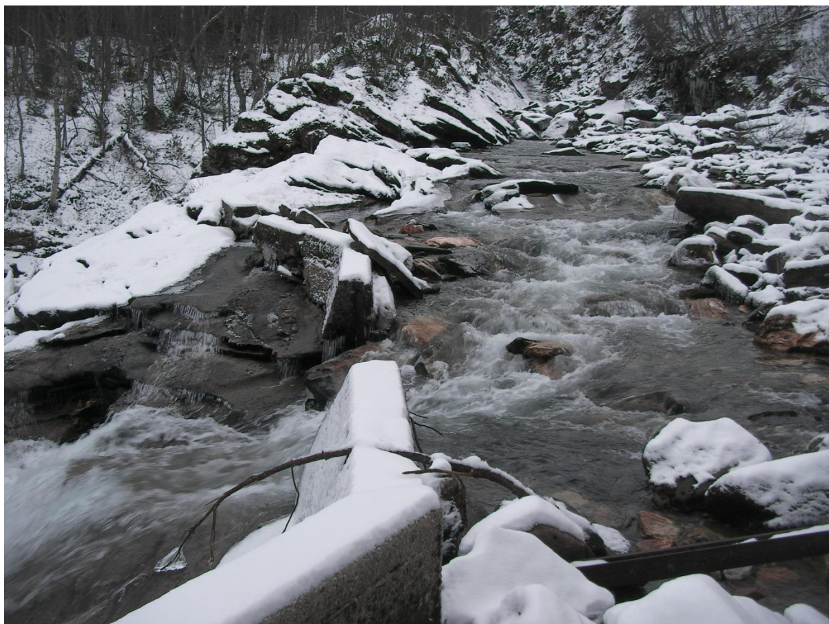
Foto 11. 05.11.2013, oppstrøms kraftverksutløp og jernbanebru. (målt: 1,15 \text{ m}^3/\text{s} )
