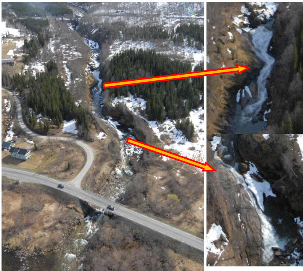
Figur 3-10. Fosser mellom E6 og jernbanelinje som fungerer som naturlige oppvandringshindere i Messingåga.
