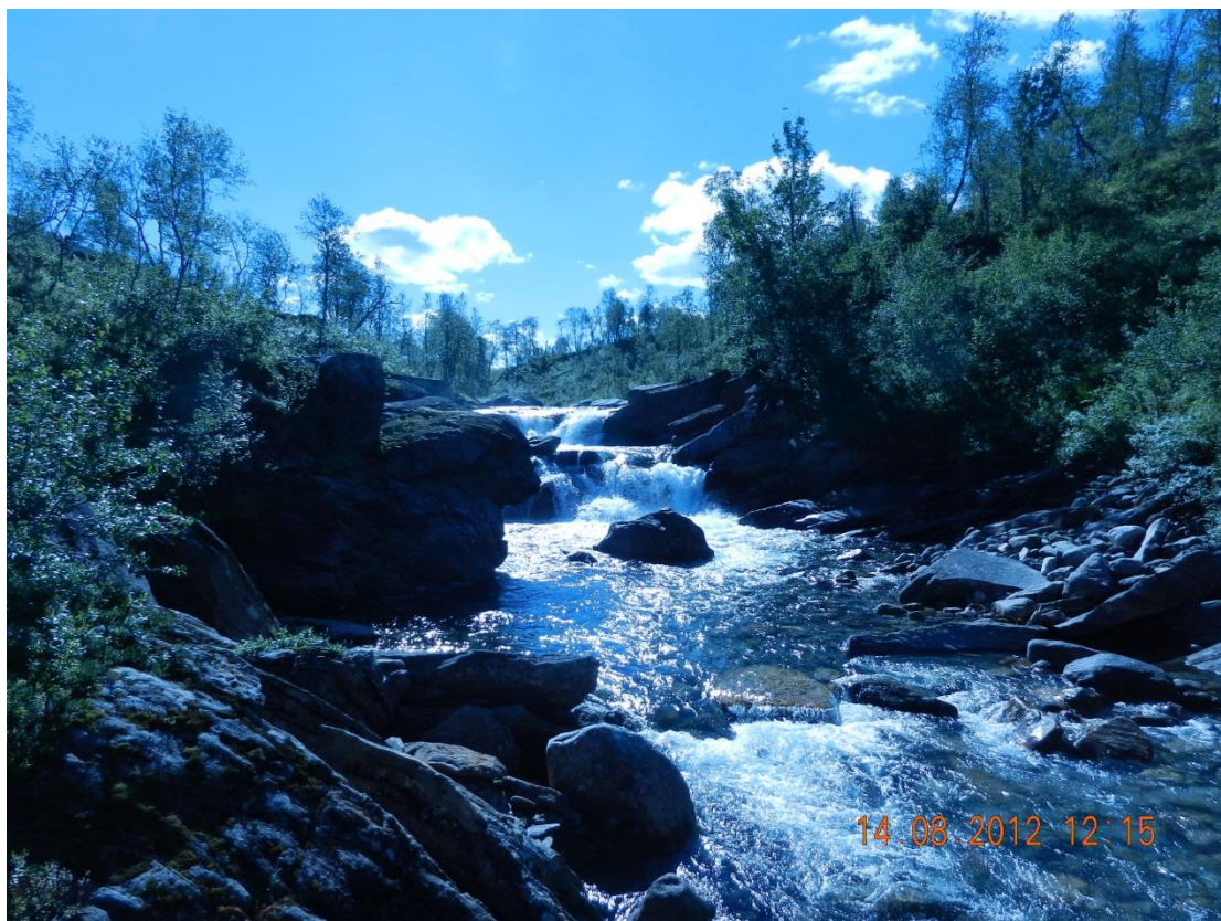
Foto 3. 12.08.2012. Damsted ved foss øverst i bildet (+403). Ca vannføring: 2,5 \text{ m}^3/\text{s} .
