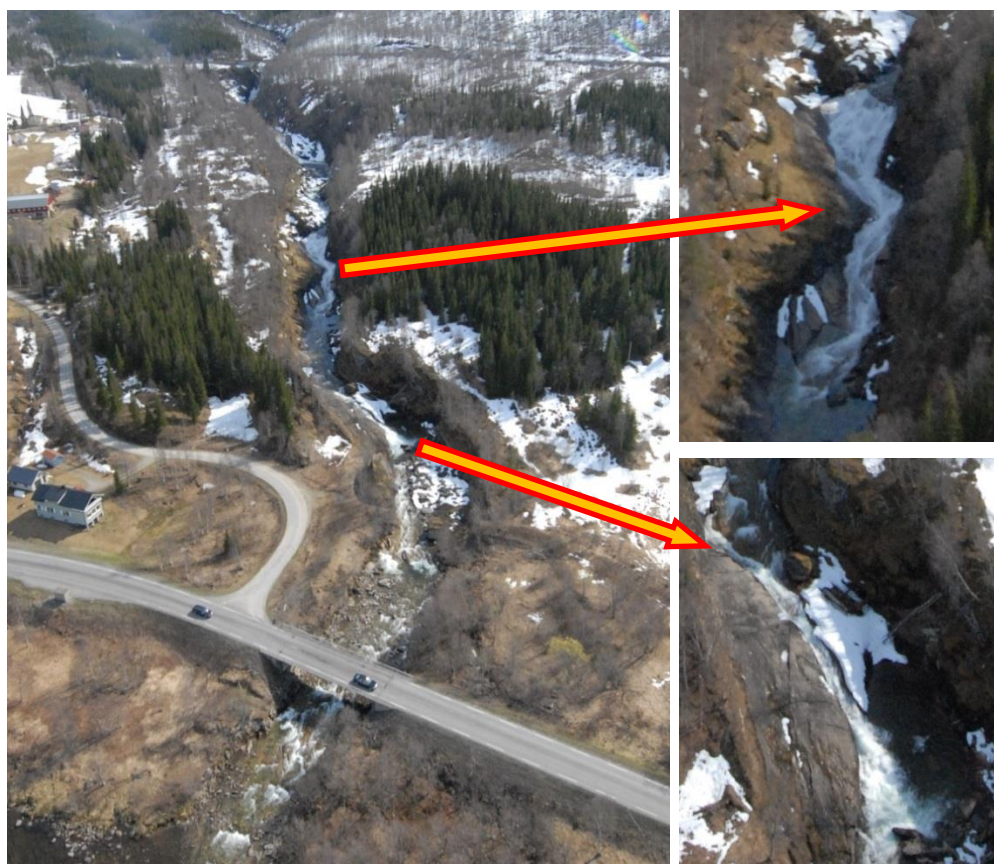
Figur 4-6: Fosser mellom E6 og jernbanelinje som fungerer som naturlige oppvandringshindere i Messingåga.
