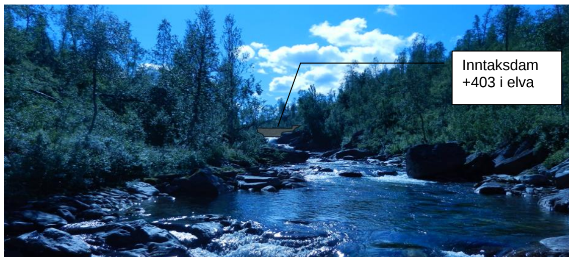
Figur 2-2 Sted for antatt inntaksdam i Messingåga, kote +403, sett nedenfra (mot syd). HRV blir om lag 4-5m over elvebunn, ca. kote 408, og vil danne en kulp i elva. Foto: Sten Hernes Sweco Norge AS.
