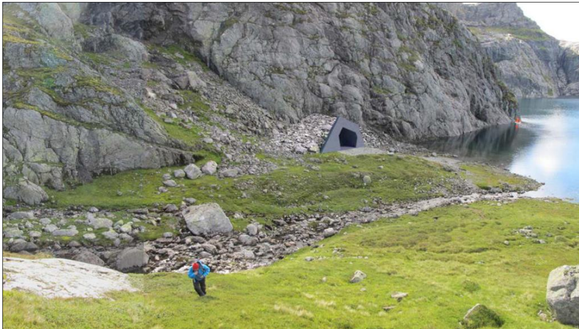
Figur 2.8. Illustrasjon. Portalbygg Blåfjell pumpe ved Stora Blåfjellvatnet.
