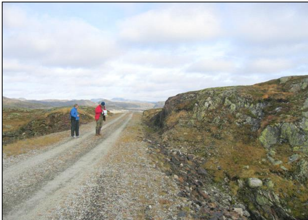
Figur 2.4. Bildet er tatt ved inntaksstedet i Vatn 1066. På første del av strekningen må det sprenges skjæring og grøft langs vegen.
