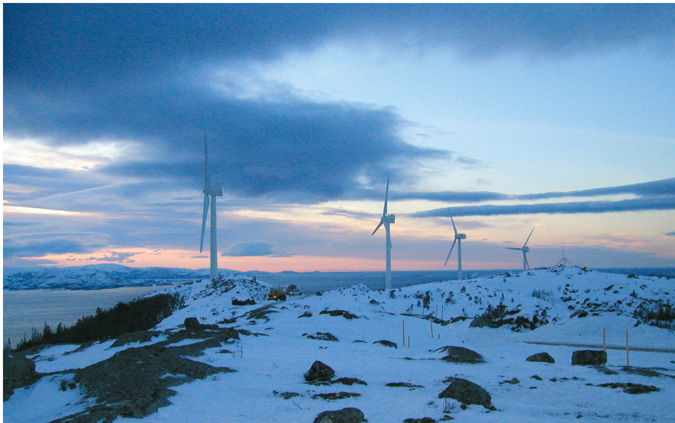
Hundhammerfjellet Vindmøllepark under etablering.
