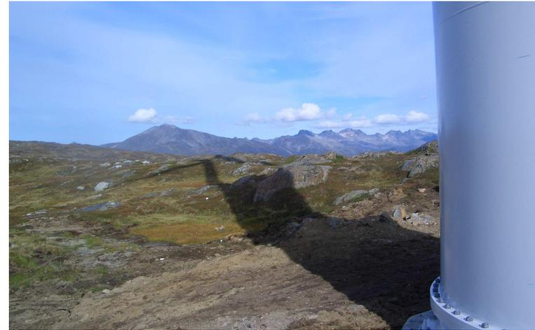
Figur 6.19. Skyggekast fra en vindmølle
