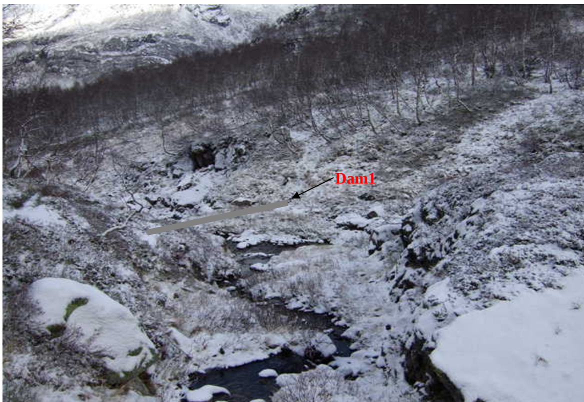
Bildet er tatt mot nord/nordøst og viser dam1.
