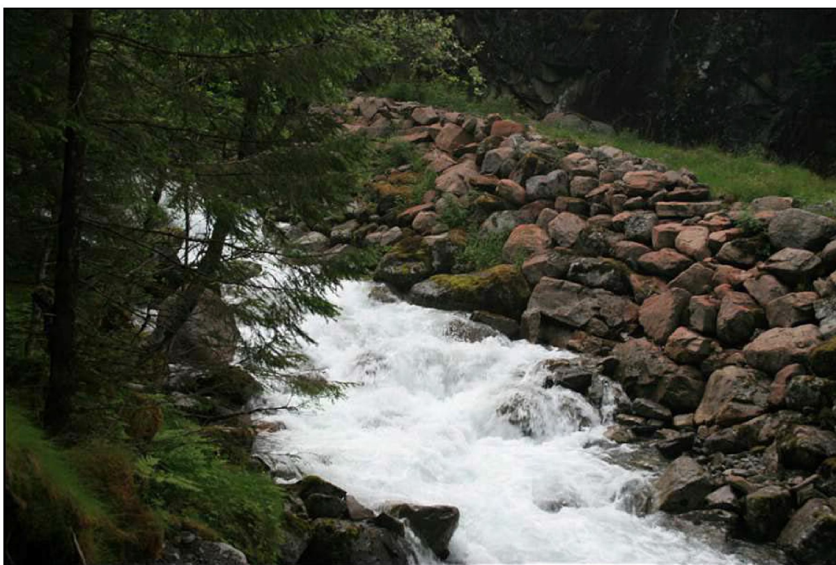
Fig. 5.8 Botnaelvas nedre del, flomsikringstiltak.
