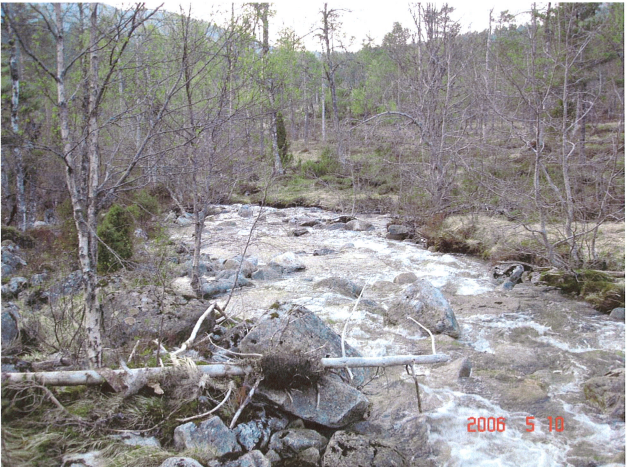
Inntaksområde oppstraums planlagt overløpsdam
