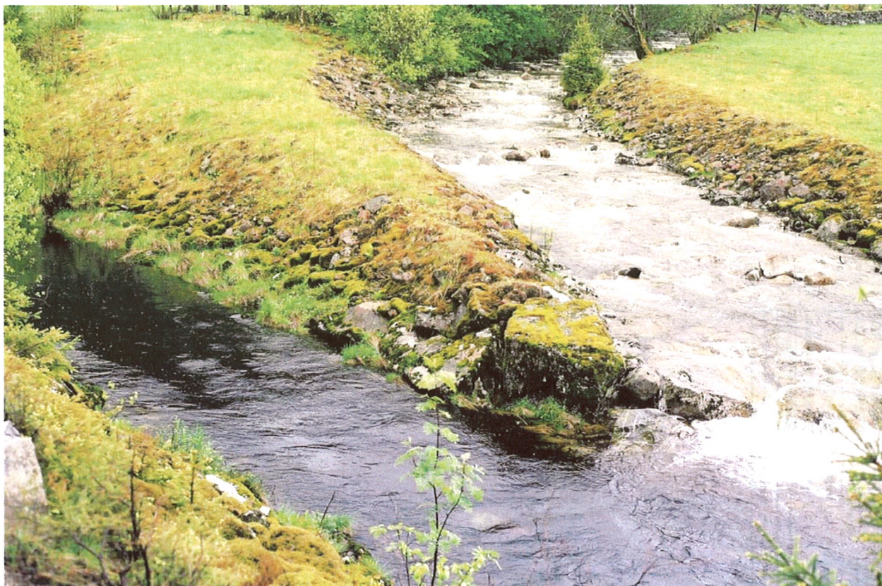
Bekk langs E39 renn saman med Senesetelva oppstraums stasjon.
