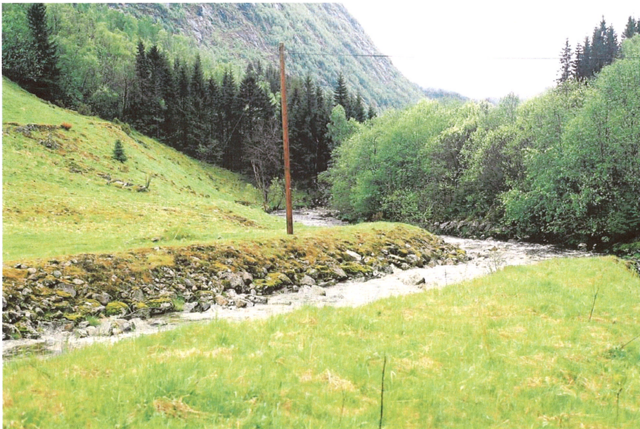
Område for planlagt kraftstasjon. Stasjon plassert på andre sida av elva midt i bildet.
