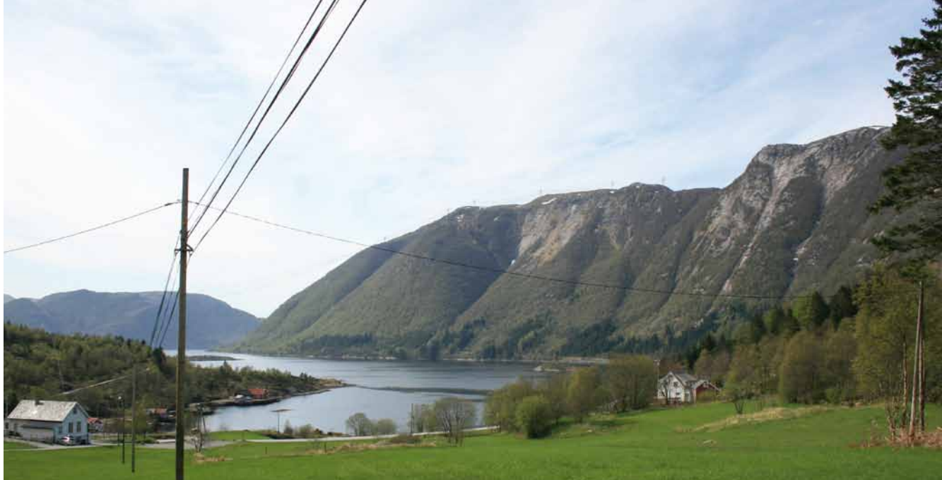
Kraftledningen sett fra Haveland (stålmastløsning).
