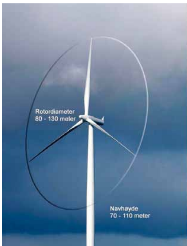
Figur 6-3 Dimensjoner på aktuelle vindturbiner
