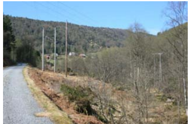
Figur 2-14 Flere høyspentlinjer krysser Tangedal på vei mot Frøyset transformatorstasjon
