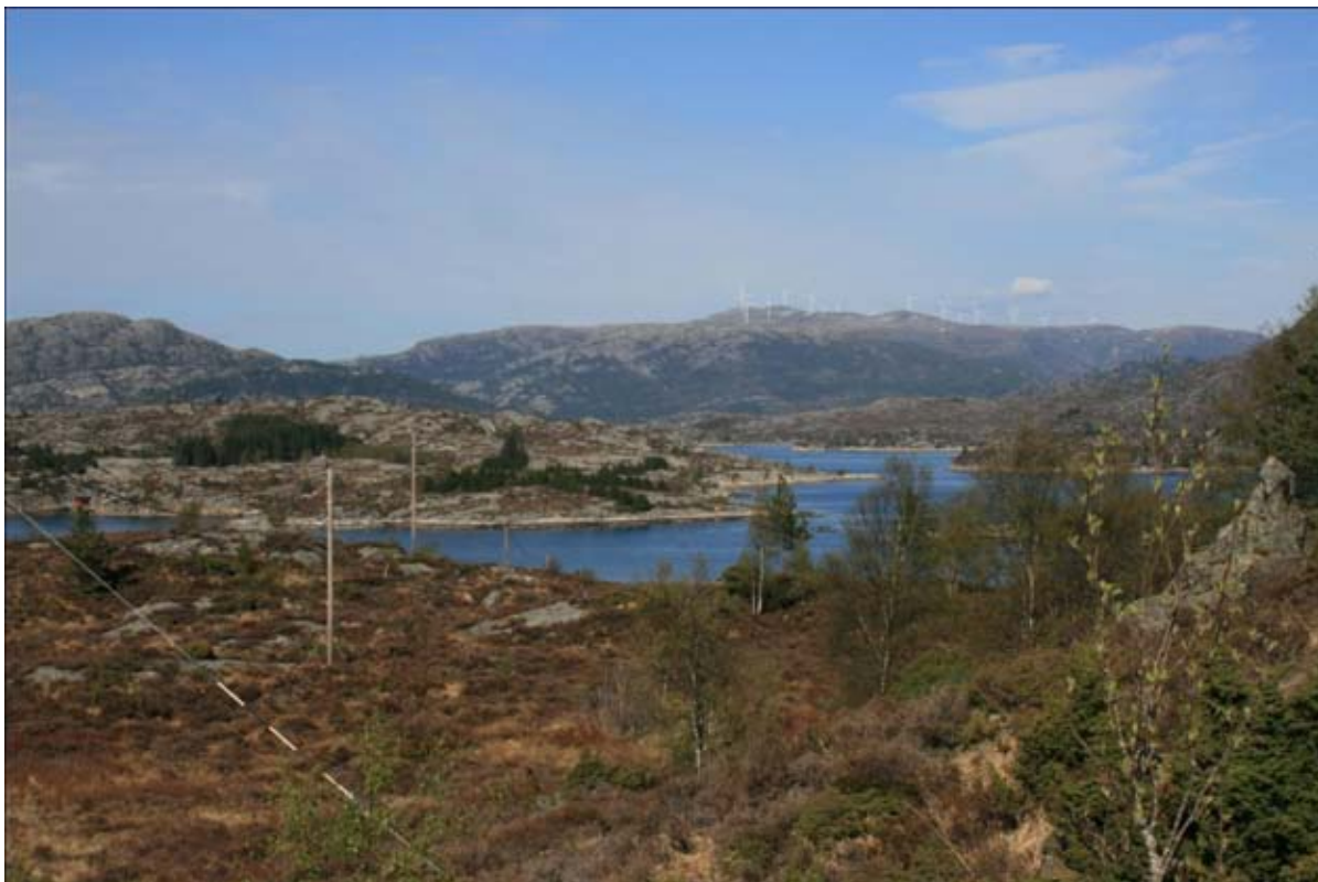
Figur 8: Vindkraftverket sett fra Sandøy. Flere bilder er satt sammen til en panoramaserie.
