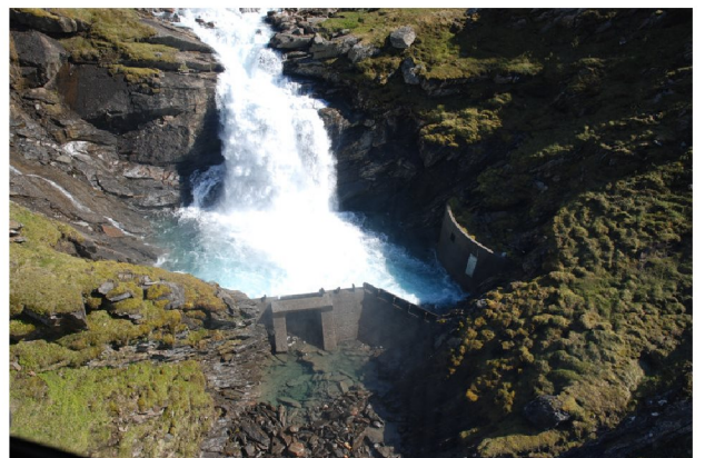
Eksisterende bekkeinntak i Govddesåga
