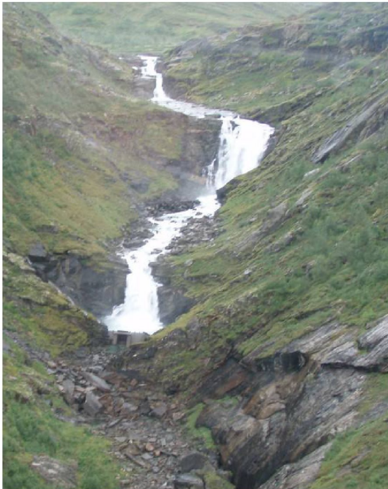
Bilde 4-1 Eksisterende bekkeinntak
