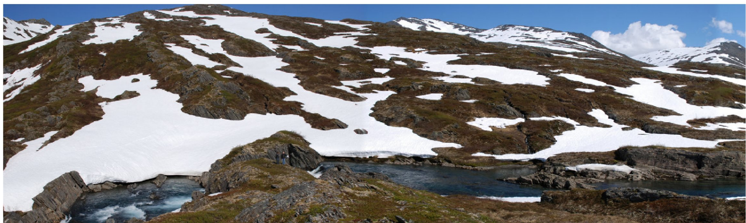
Inntaksområdet på kote 546,5
