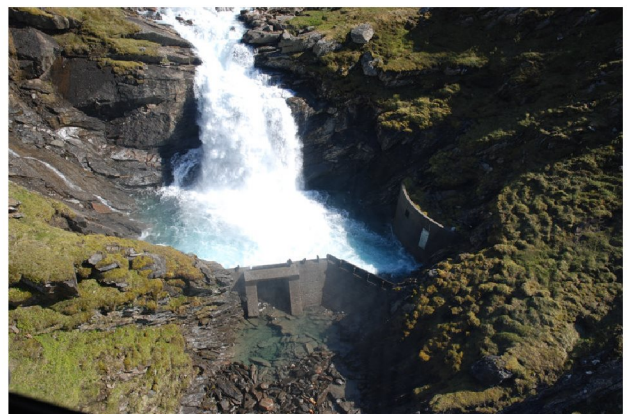
Eksisterende bekkeinntak i Govddesåga
