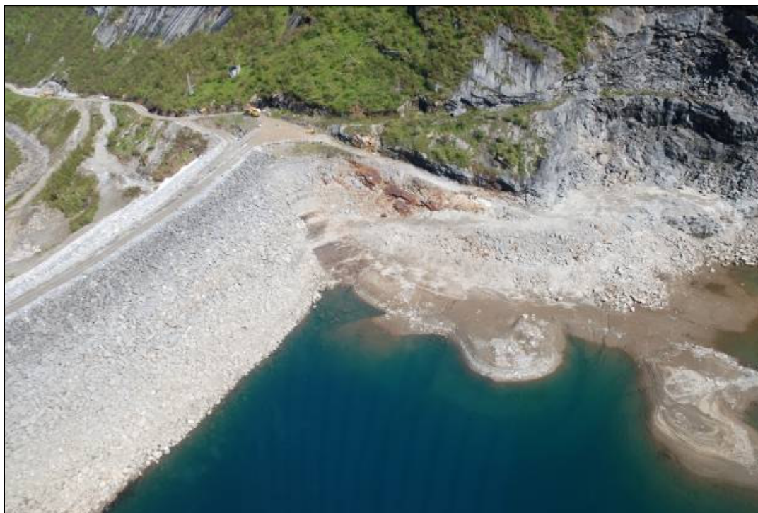
Figur 4. Bildet viser Arstaddalsdammen og steinbruddet sett mot nordøst fra helikopter (Bilde: I.Wiik, Ing. S.J.Wiik AS).
