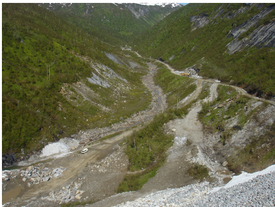
Figur 6.3 Anleggsveger, permanent veg og en tørrlagt Arstadåga nedstrøms Arstaddalsdammen (Foto: O.Kleppe, SWECO).
