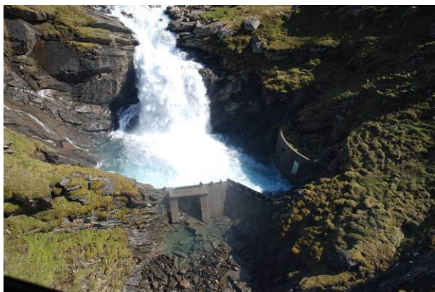
Figur 6.8 Eksisterendedam og inntak i Govddesåga (Foto: I.Wiik, Ing. S.J.Wiik AS).
