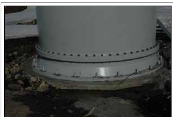
Figur 5-2: Eksempel på turbinfundament i fjell.
