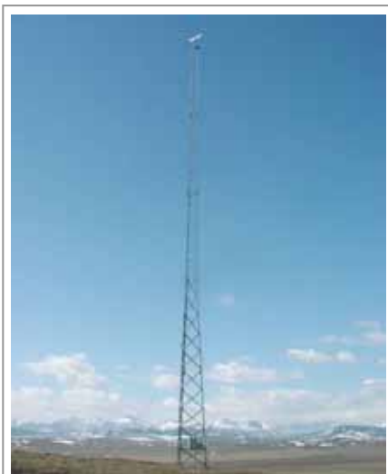
Figur 5-3 Eksempel på fagverks Meteorologimast. Kilde: Nordex.
