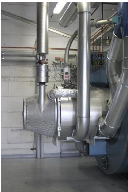
Tilsvarende biobrenselkjel med kombinert Pellets-/gassbrenner på 4 MW
