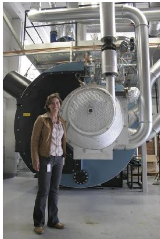
Tilsvarende biobrenselkjel med kombinert Pellets-/gassbrenner på 4 MW
