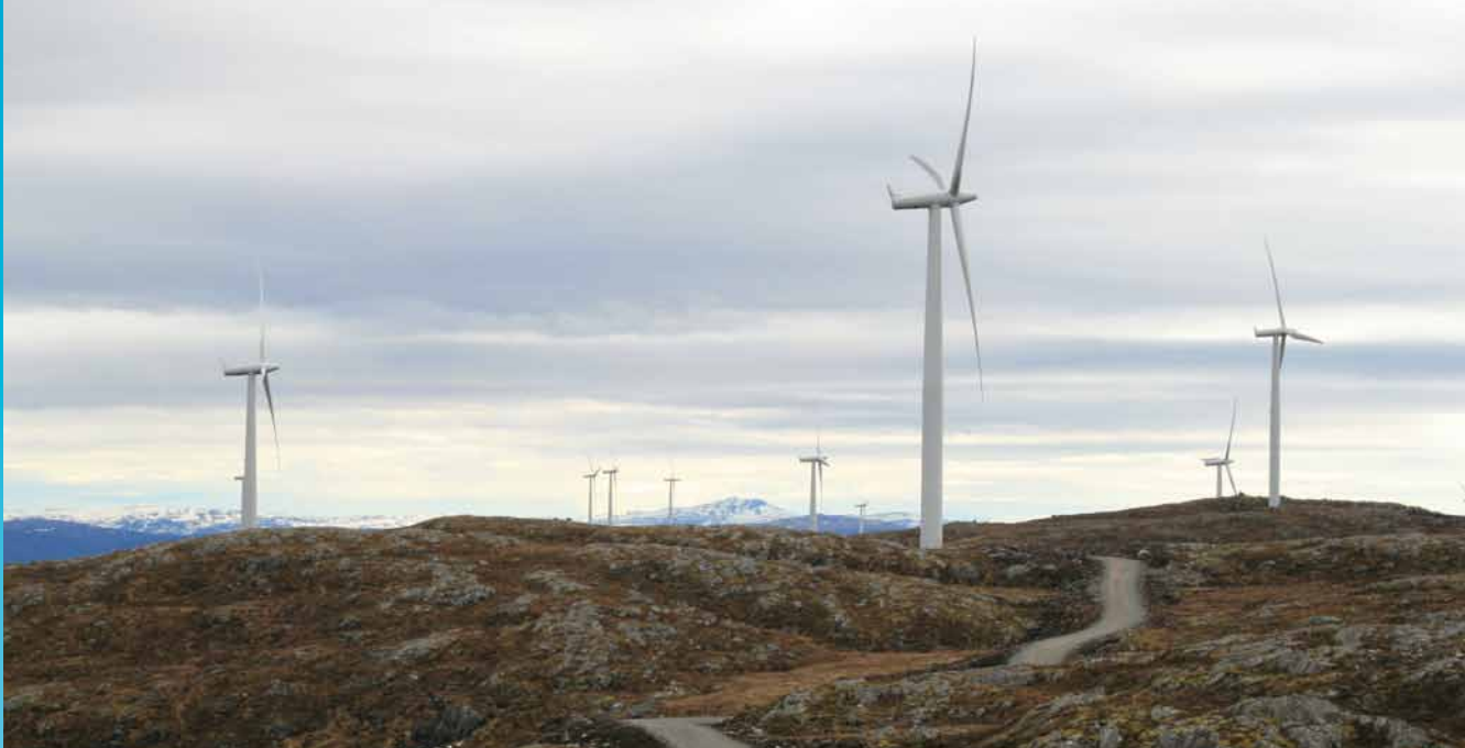
Eksempel på internvei fra vindparken på Hitra. Foto: Trond Simensen, SWECO
