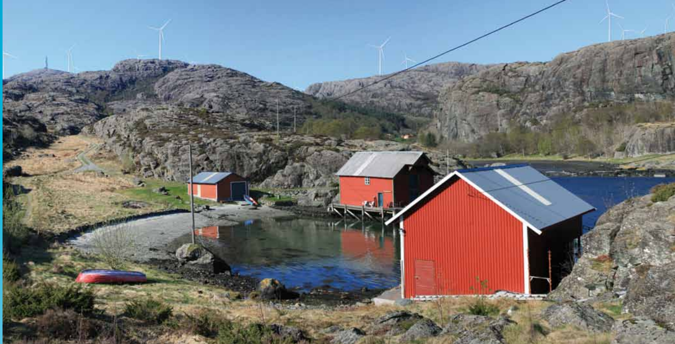
Ulvegveina vindpark sett fra Kråkevågen. Foto og visualisering: Mari-Ann Ekern, Rambøll.
