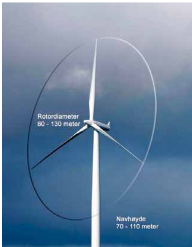
Figur 6-3 Dimensjoner på aktuelle vindturbiner
