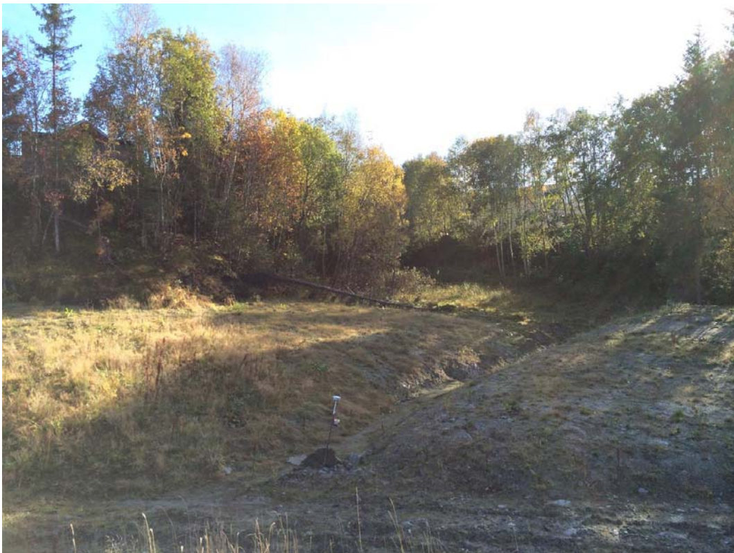
Bilde 15: Sideravine, høyre side, ca. ved P65.
