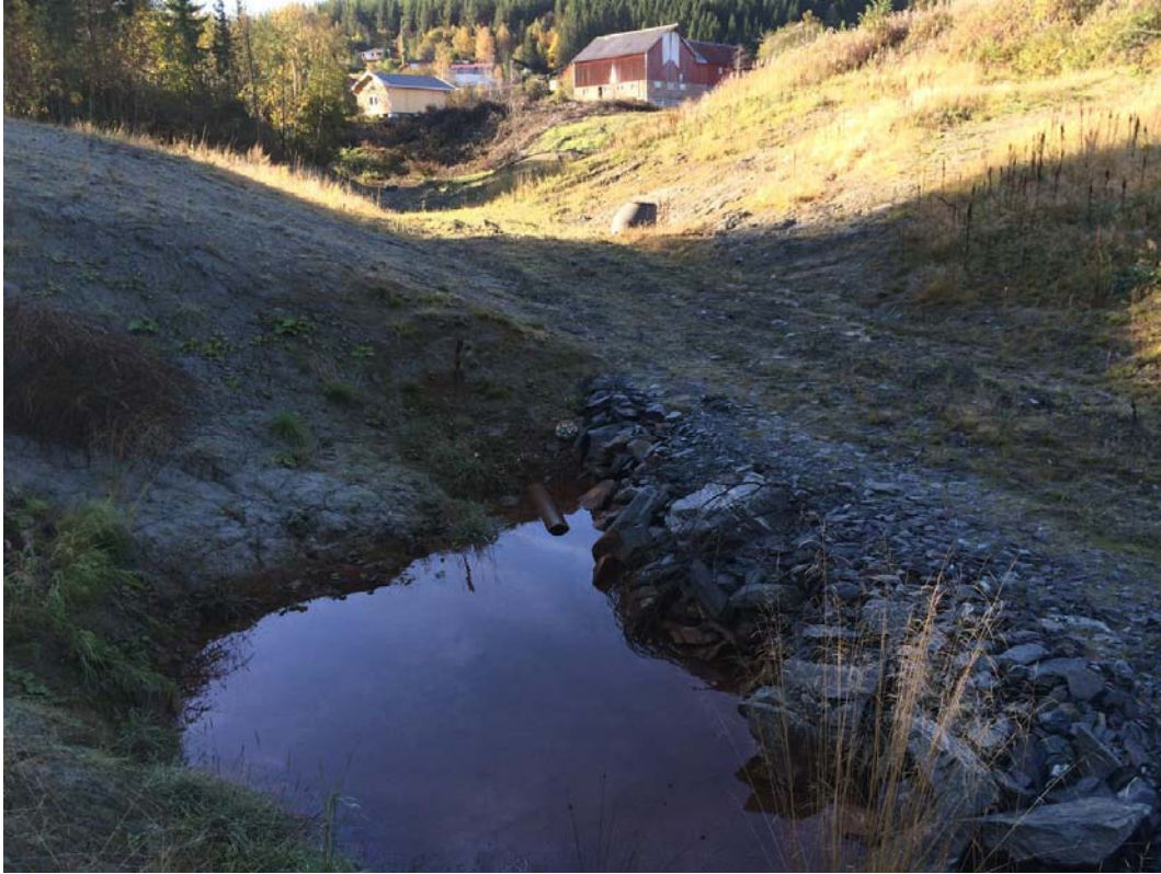
Bilde 14: Pkt «bunn roer3». Rør må forlenges slik at overvann renner ut i bekken.
