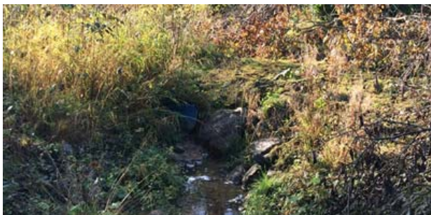
Bilde 1: Øverst til venstre: rør ved P300, øverst til høyre: rør ved P100, nederst: rør ved P0
