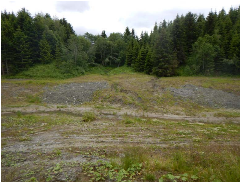
Figur 24: Erosjon i leirmassene, Sunndalsbekken P900, venstre side
