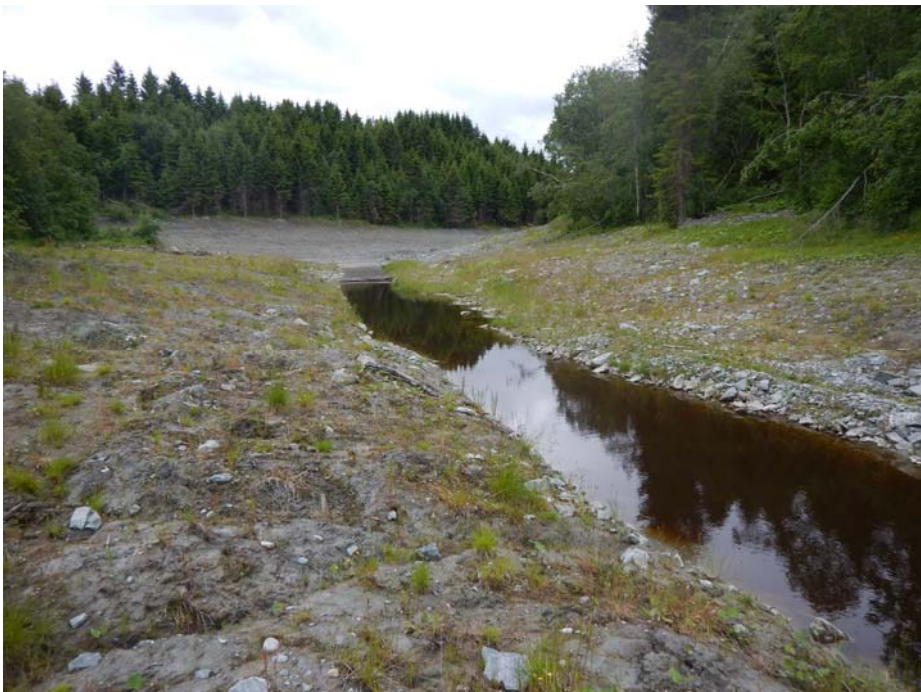
Figur 36: Sett nedover Osbekken fra P190
