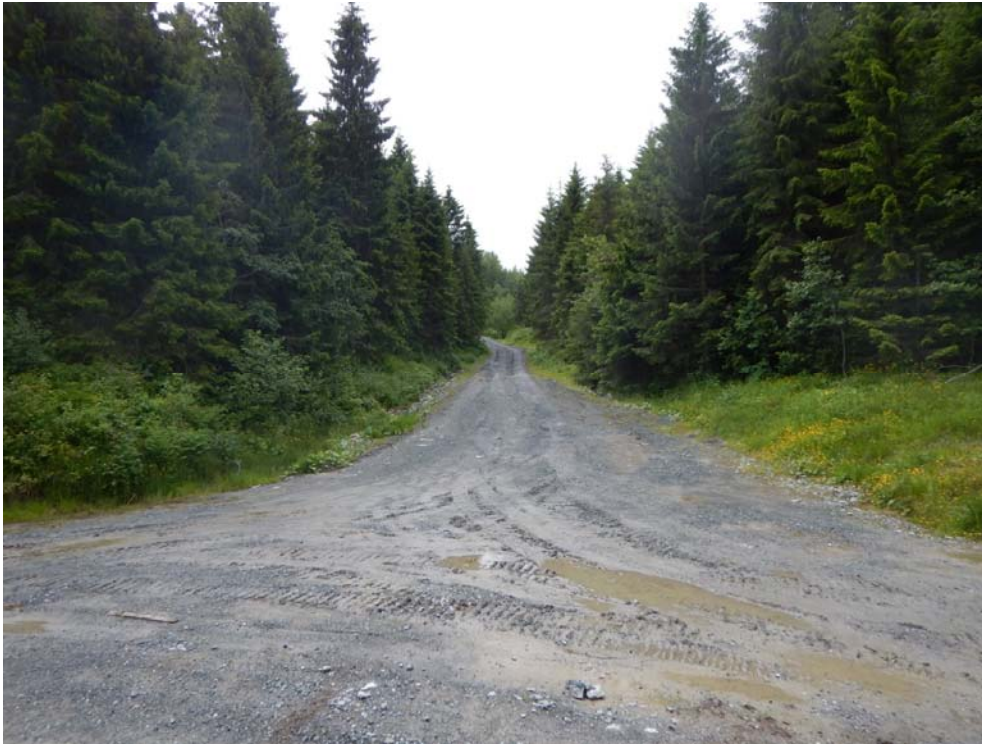
Figur 43: Anleggsvei opp mot avlasting I
