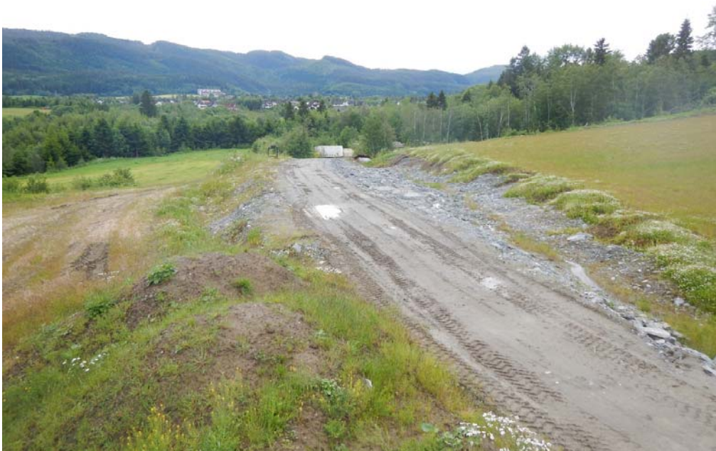
Figur 50: Anleggsvei gjennom avlasting I
