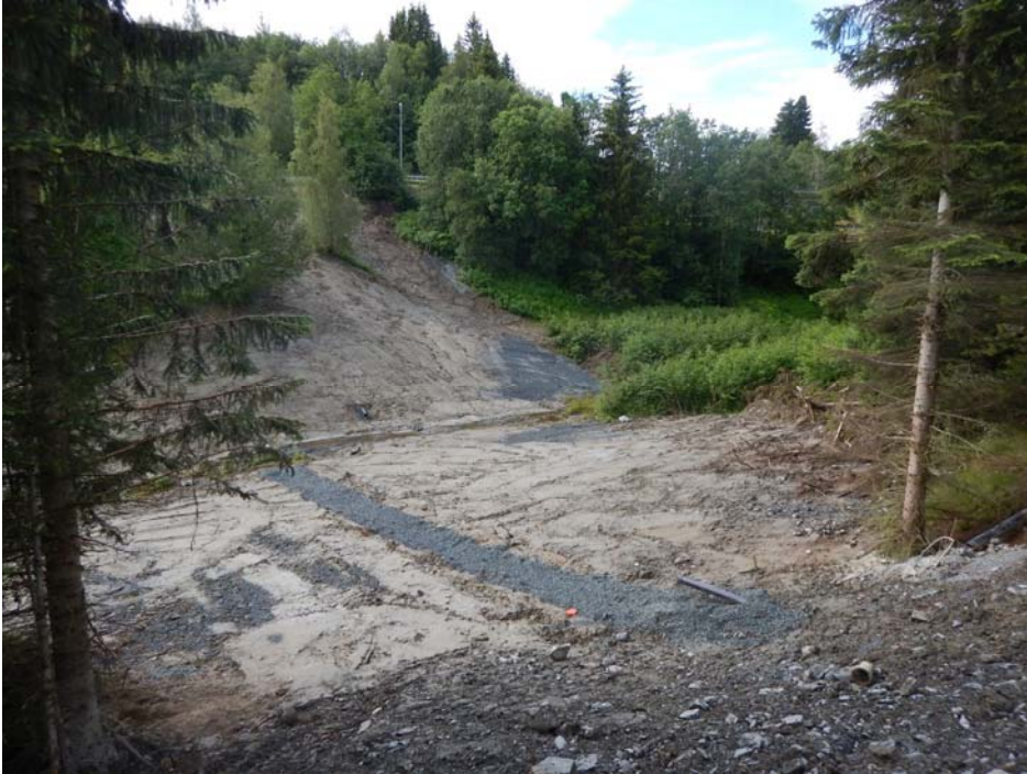
Figur 7: Kommunalt tiltak over Sunndalsbekken (ca. ved P50)
