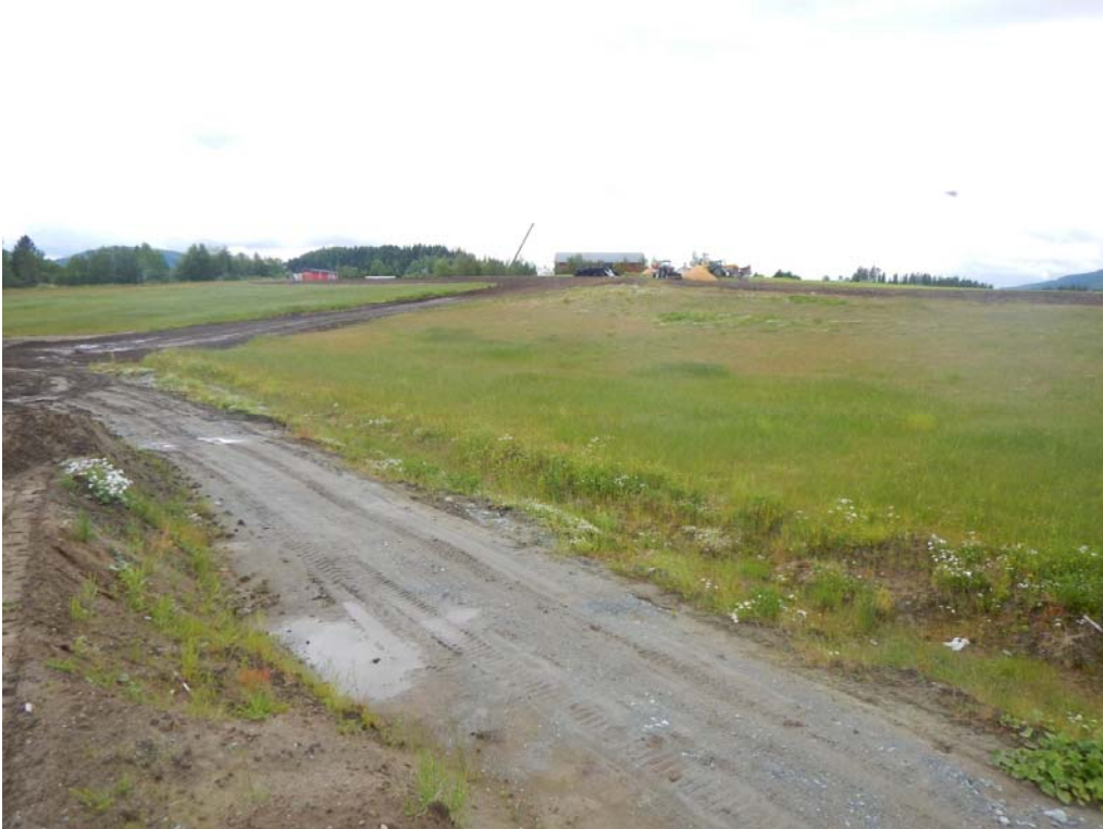
Figur 47: Anleggsvei gjennom avlasting I
