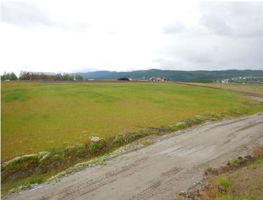
Figur 48: Anleggsvei gjennom avlasting I
