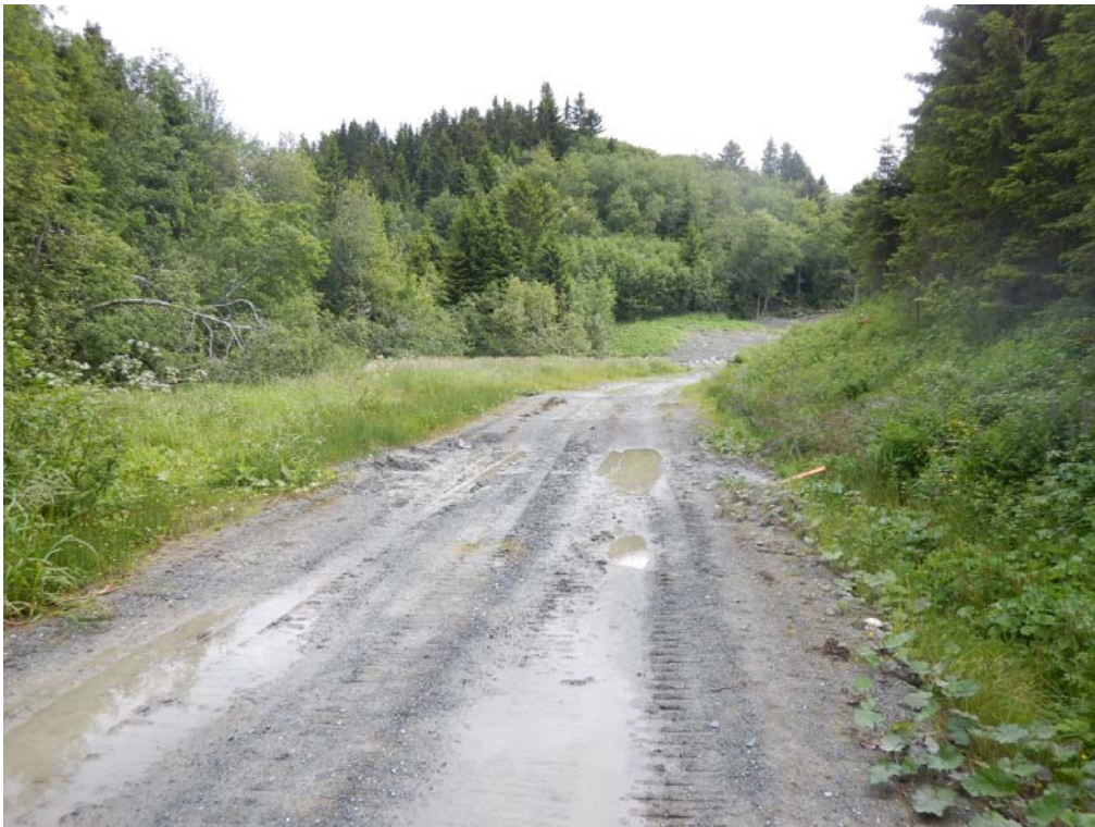
Figur 40: Anleggsveien opp mot P1200 Sunndalsbekken
