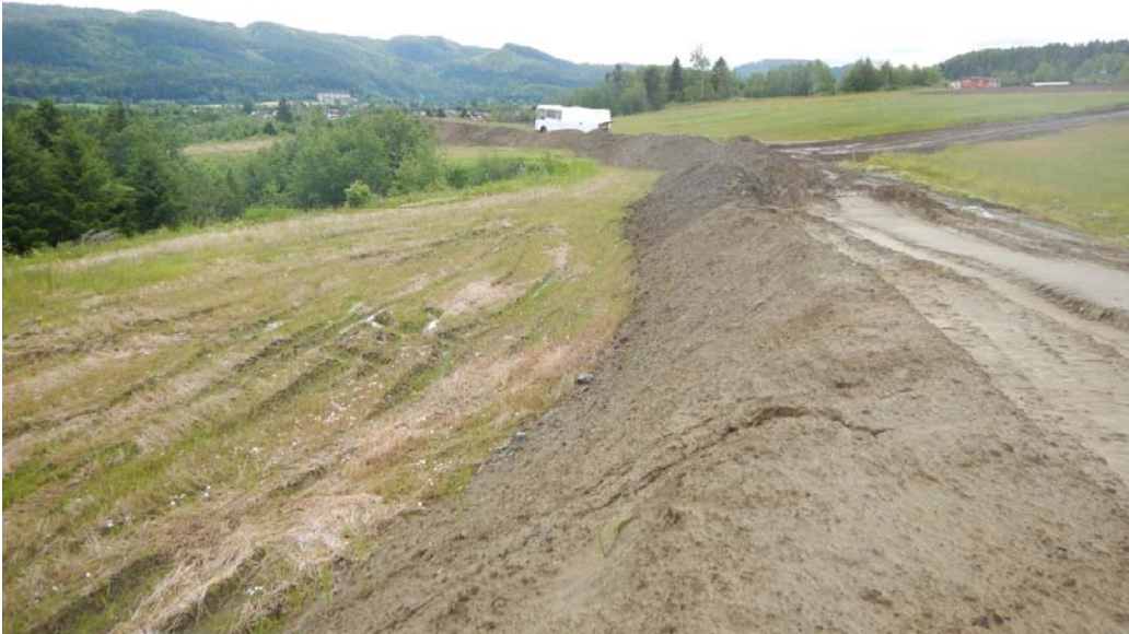
Figur 45: Jordranke og anleggsvei gjennom avlasting I
