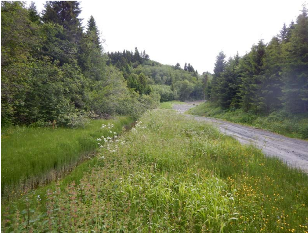
Figur 41: Anleggsvei og bekk sett i oppstrøms retning
