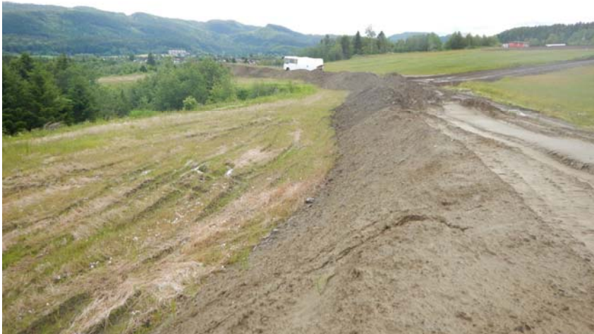
Figur 4: Jorddranker langs anleggsveien gjennom avlasting I
