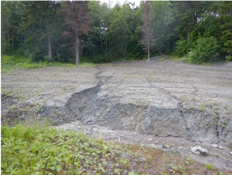
Figur 2: Erosjon i leirmassene ca. ved P500 i Sunndalsbekken
